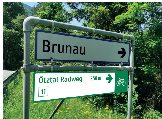
Beispiel Schild 1460x325cm und Montage unter KFZ-Schild.
