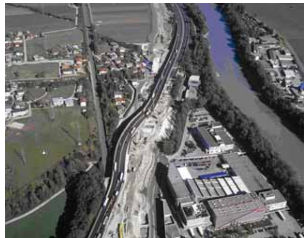
Abb. 2-7: Luftbild der Baustelle Unterinntaltrasse (Quelle: BEG, Alpine Luftbild)
