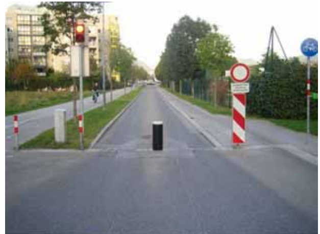
Abb. 1-28: Beispiel Durchstich Gumpstraße in Innsbruck (Quelle: IVB)
