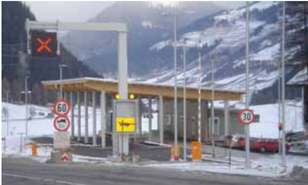
Abb. 1-34: Kontrollstelle Nauders in Bau
