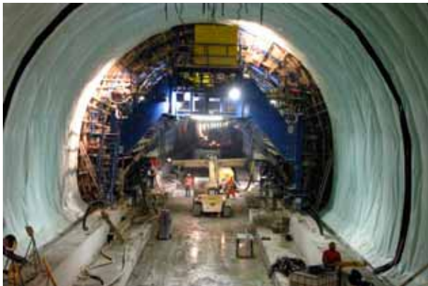
Abb. 2-9: Tunnel Innenausbau (Quelle: BEG)
