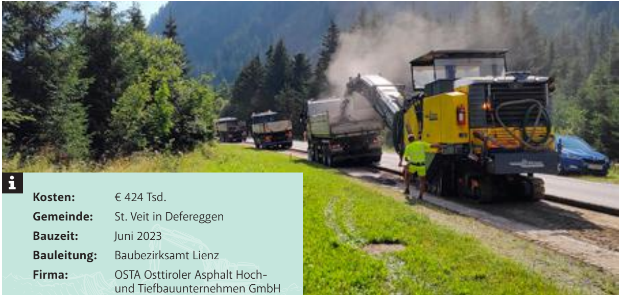
Abtragsfräsen der bestehenden Asphaltsschichten
