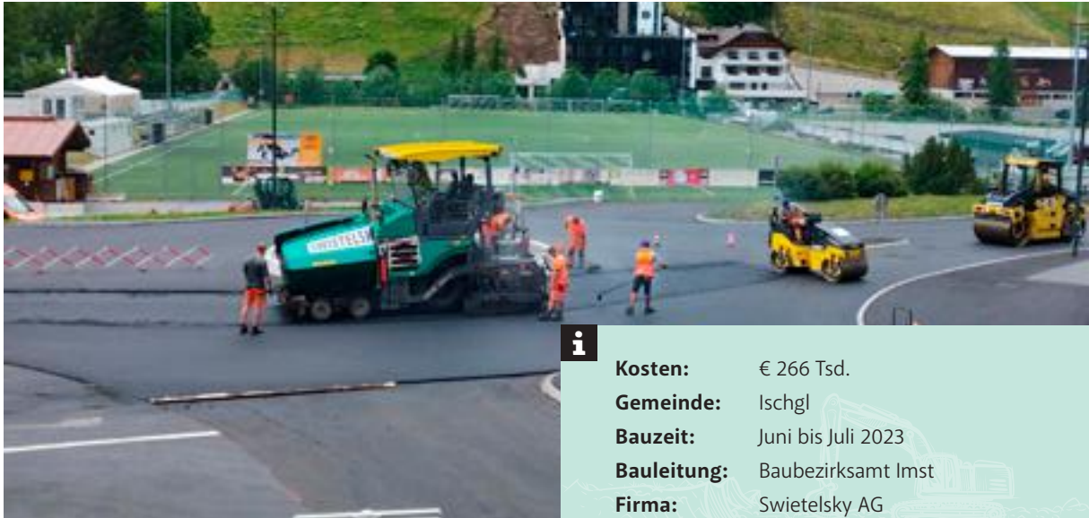
Asphaltierung des Kreisverkehrs
