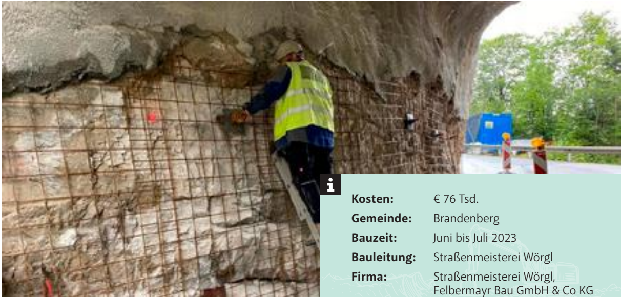
Neu errichtete Spritzbetonschale
