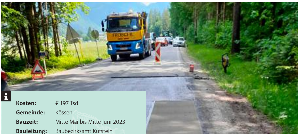
Einbau eines Asphaltvlieses zur Erhöhung der Tragfähigkeit
