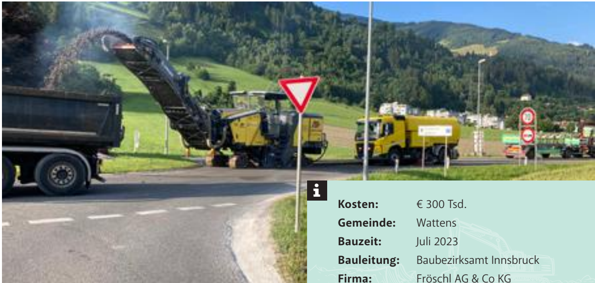
Abfräsen der Deckschicht im Kreisverkehr
