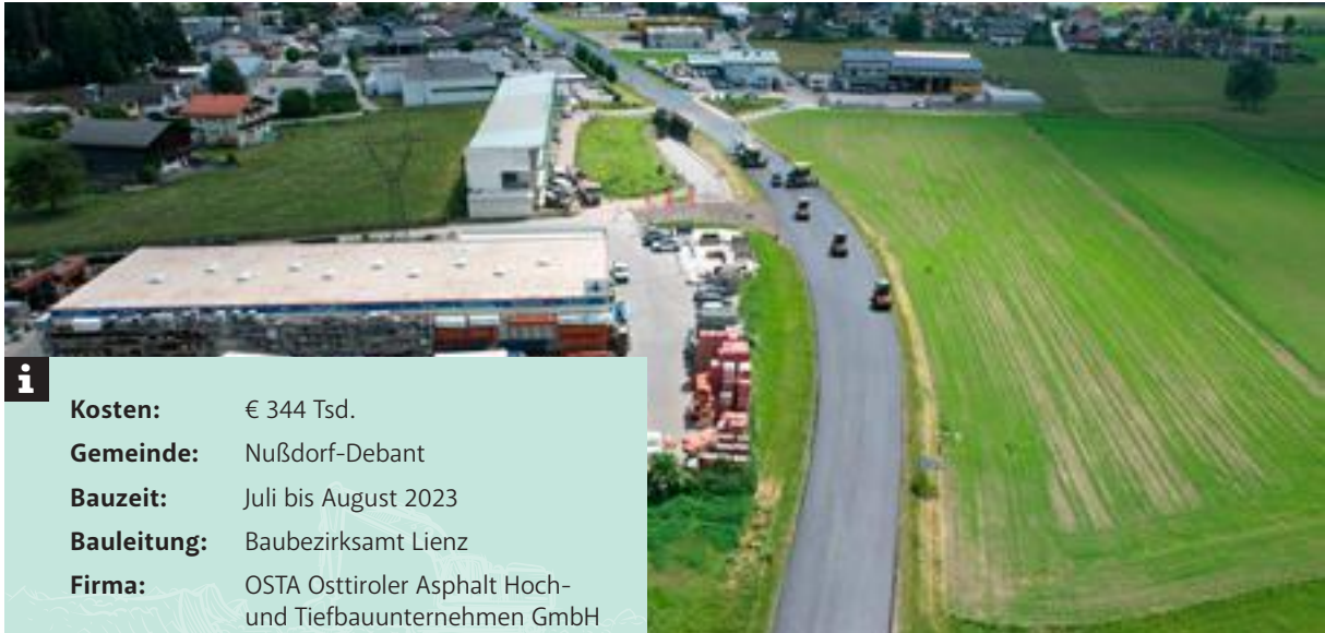
Gestaffelter Asphalteinbau aus der Vogelperspektive
