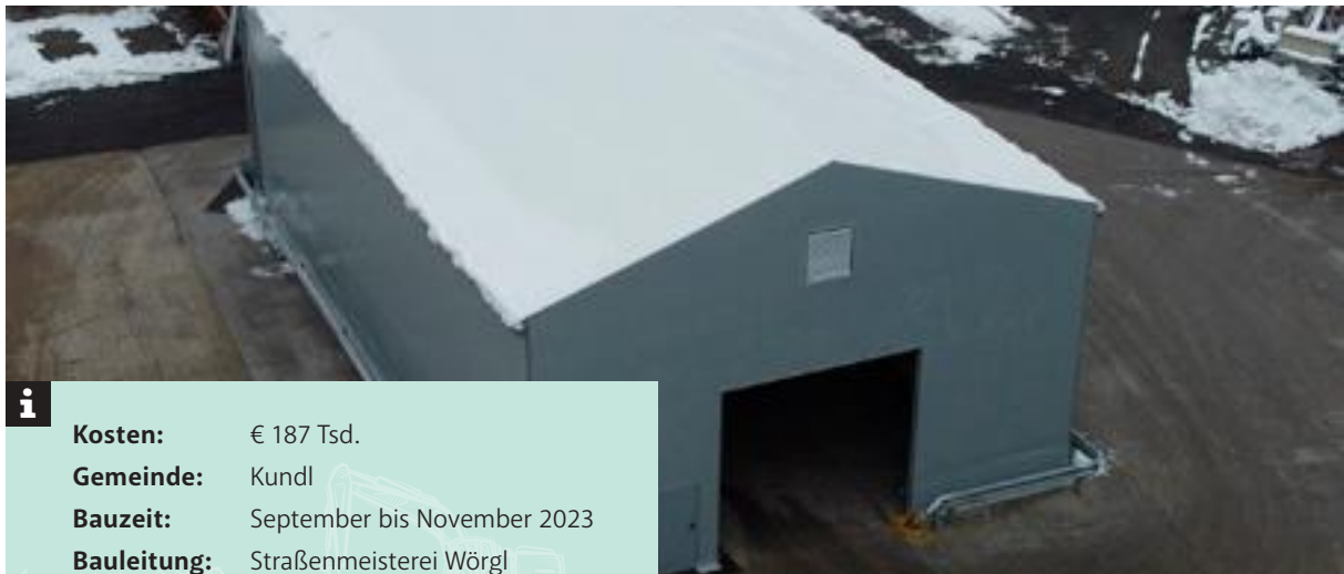
Lagerzelt mit Einfahrtstor und Leitschienen als Anprallschutz
