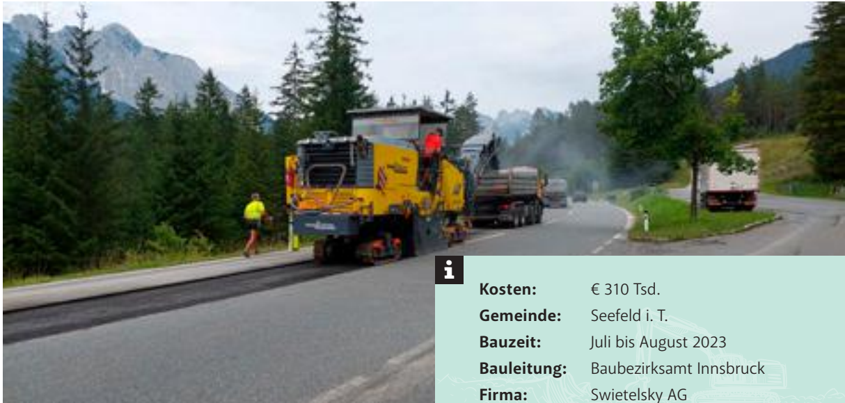
Fräsen der bestehenden Fahrbahn
