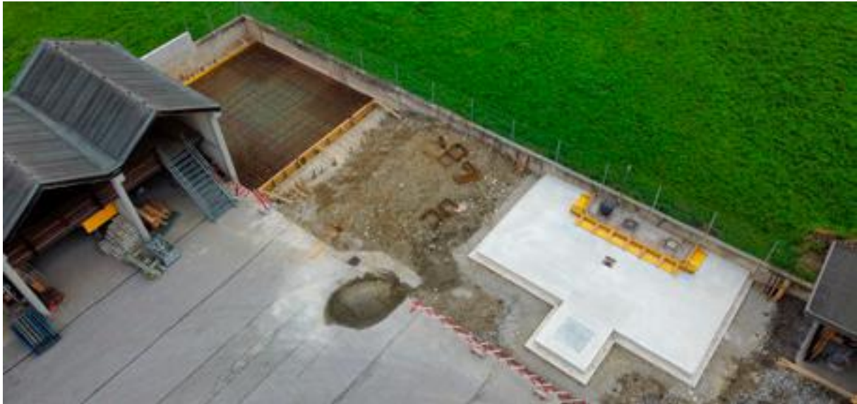
Ansicht von oben während der Bauphase
