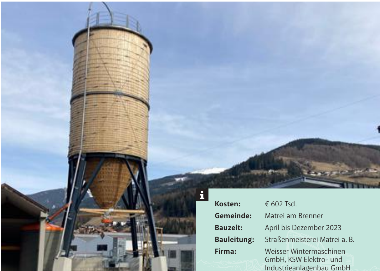
Neuer Silo mit Soleanlage
