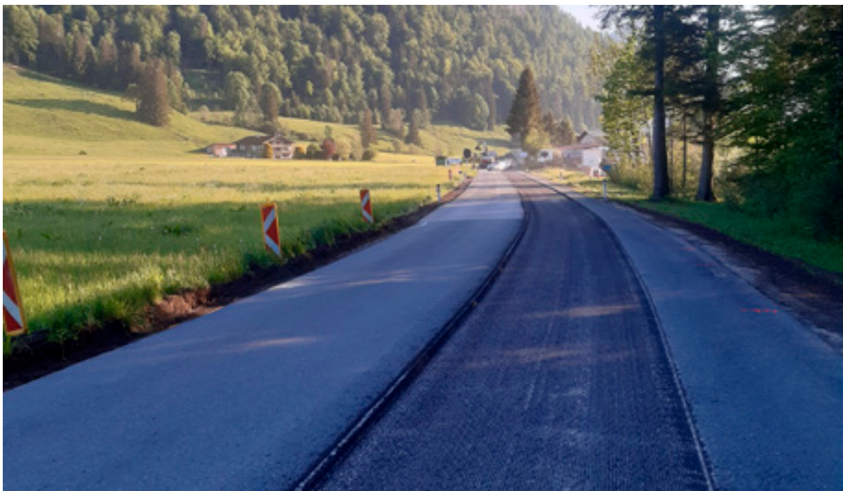
Die B 172 Walchseeestraße wird für eine neue Asphaltschicht vorbereitet
