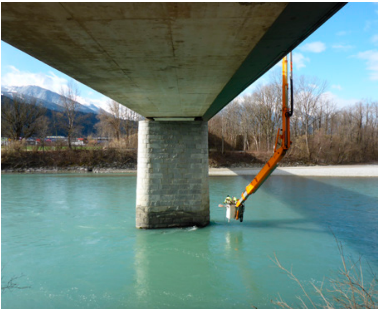
B 171b Kranebitter Innbrücke
