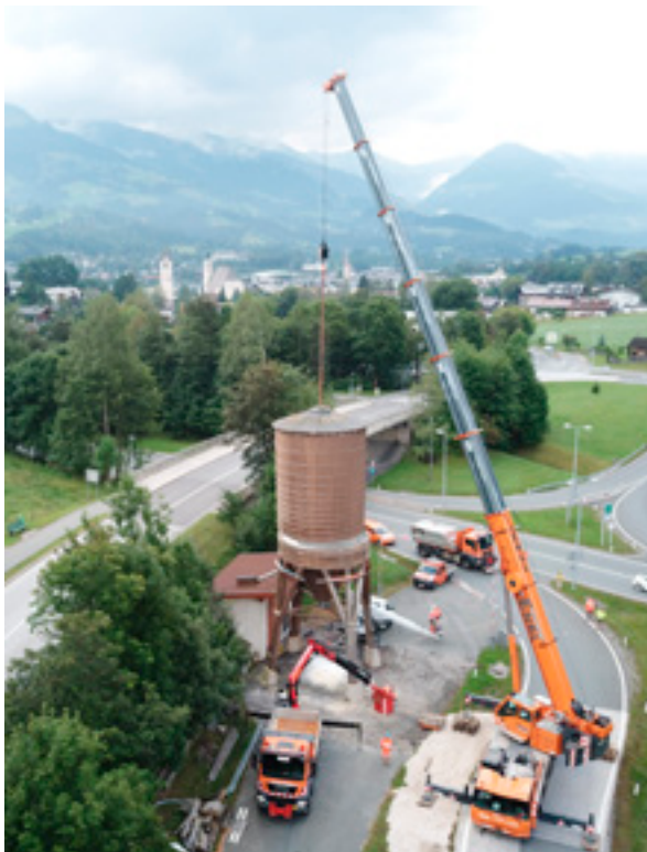
Abbruch des alten Silos durch die Straßenmeisterei St. Johann
