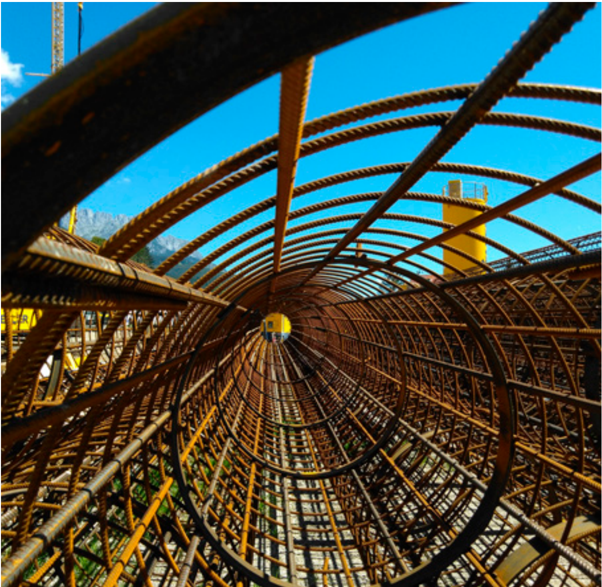
B 178 Unterflurtrasse Scheffau
