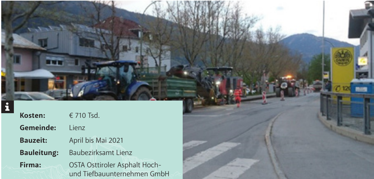
Abtrag der bestehenden Asphaltdecke
