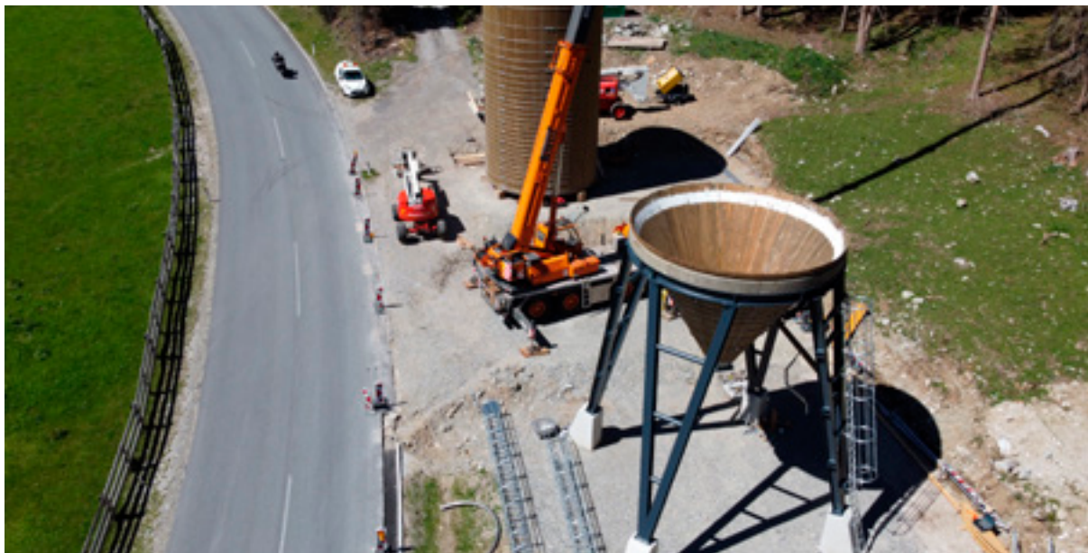
Stahltragkonstruktion und Trichter sind fertiggestellt
