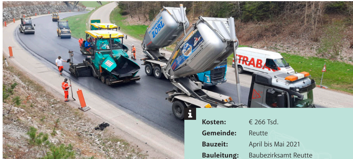
Nahtloser Asphaltdeckschichteinbau durch Einsatz von 2 Asphaltfertigern
