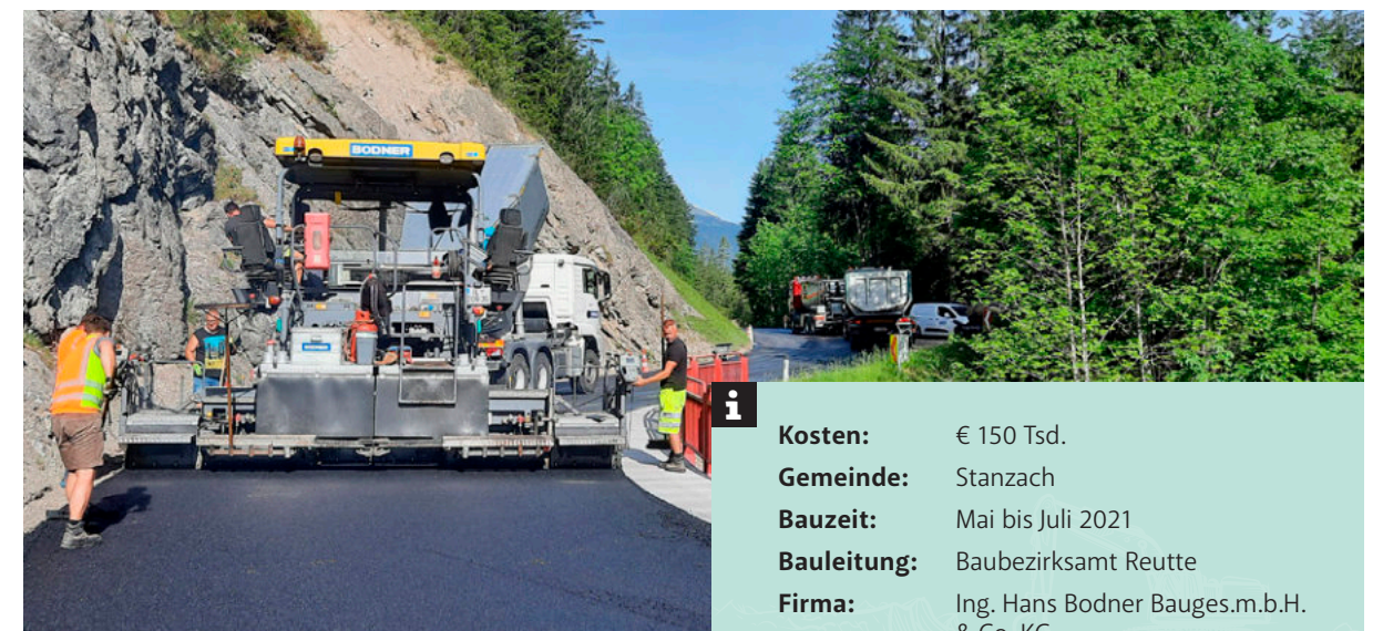
Asphaltfertiger baut die Asphaltdeckschicht vollflächig ein.
