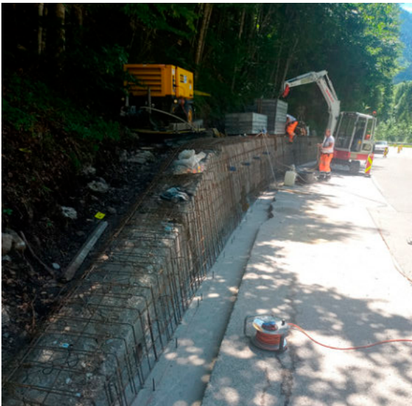
Die Mauer wird mit einer neuen Betonvorsatzschale saniert.
