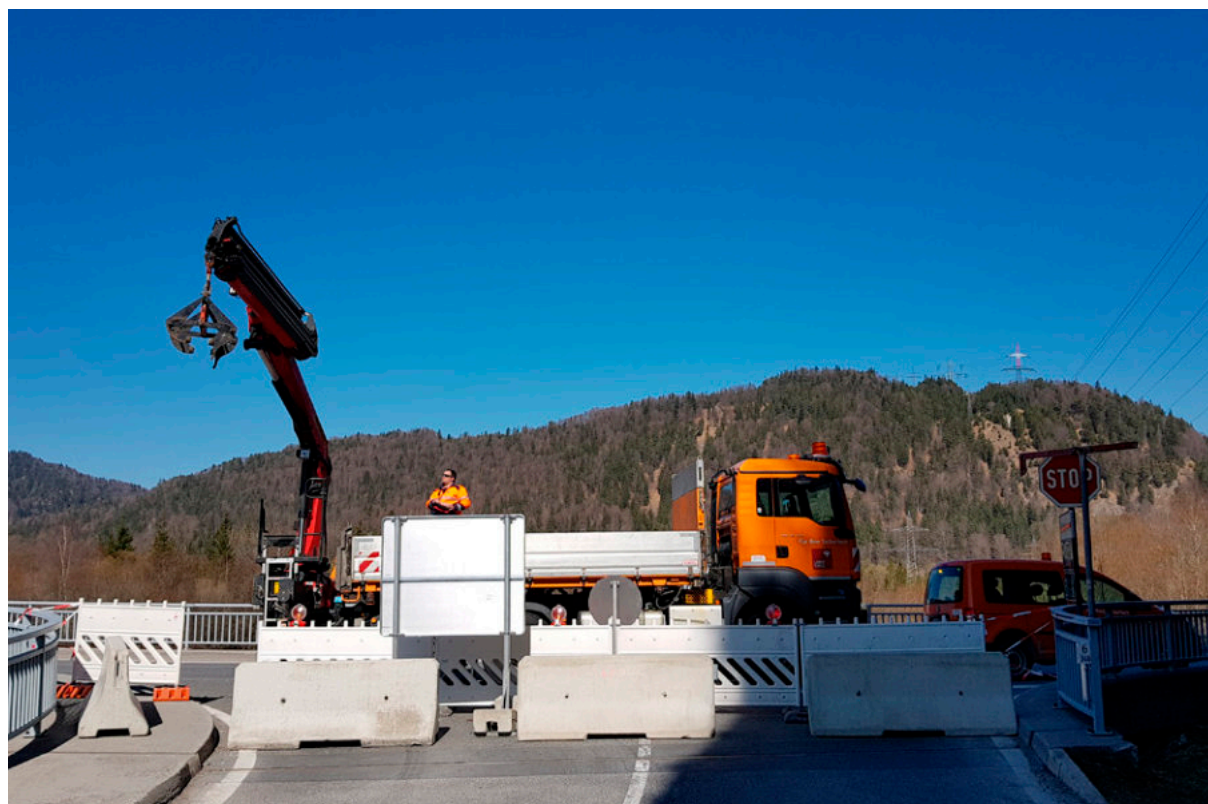
Nachfolgend werden ausgewählte Beispiele für die Leistungen der Straßenmeistereien dargestellt.
