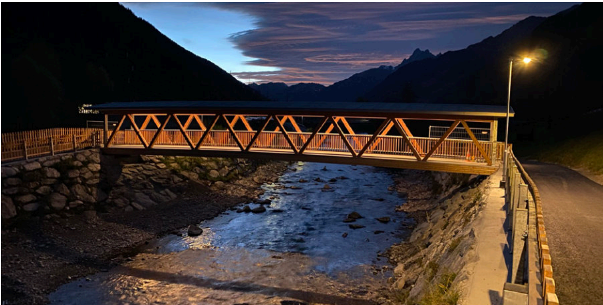
Rad- und Fußgängerbrücke Schnann
