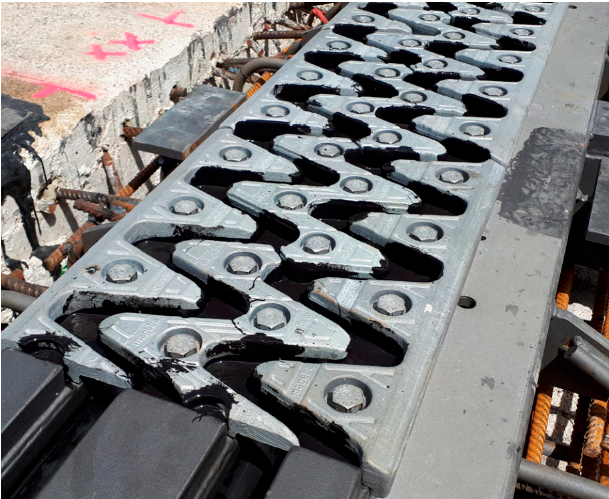
Fahrbahnübergang B 186 Ötztalstraße Habichener Brücke
