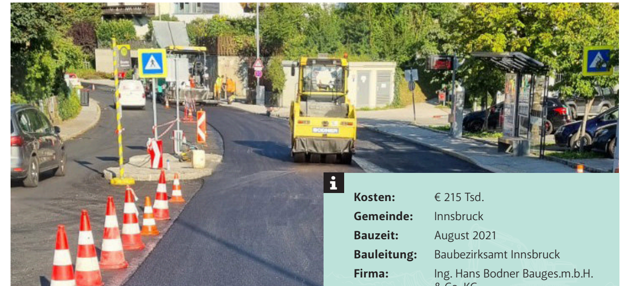
Einbau der Asphaltdeckschicht auf der L 8 Dörferstraße
