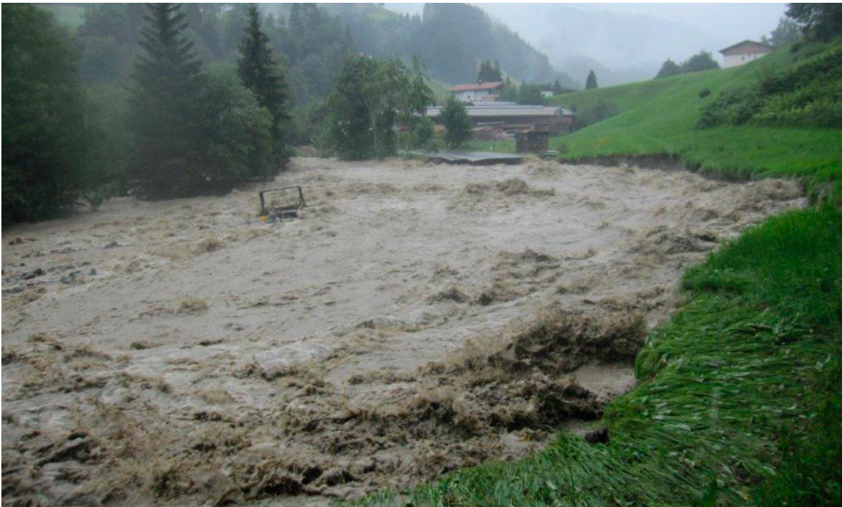
L 205 Kelchsauer Straße wird durch Kelchsauer Ache zerstört
