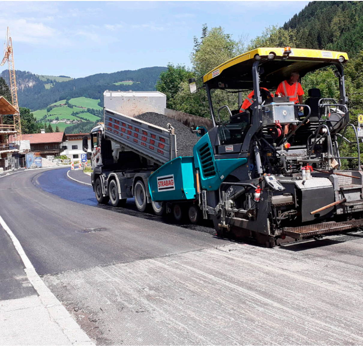
Der Asphaltfertiger bringt die Asphaltdeckschicht auf der L 3 Wildschönauer Straße auf.
