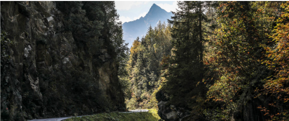
Als größtes Radwegprojekt im Paznaun wurden seitens des Tourismusverband Paznaun – Ischgl im Jahr 2021 umfangreiche Optimierungsarbeiten entlang des Radweges zwischen Ischgl und Galtür im Bereich „Kind“ umgesetzt.
