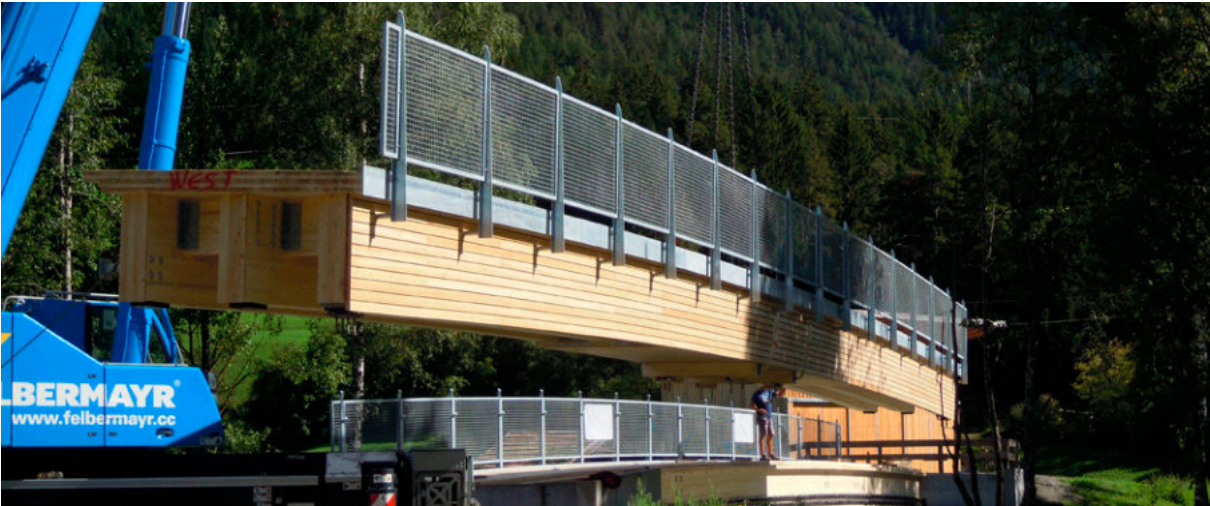
Ein wichtiger Lückenschluss des Stanzertalradweges in der Gemeinde Pettneu am Arlberg wurde mit dem Einhub der neuen Rad- und Loipenbrücke im Ortsteil Schnann durch den Tourismusverband St. Anton am Arlberg hergestellt.
