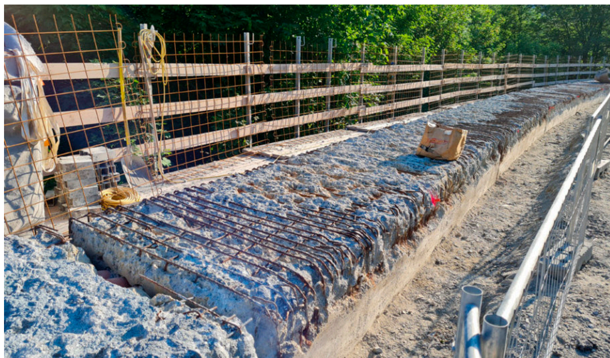
L 38 Ellbögener Straße, Pfoner Eck bis Sillbrücke Mühlbachl
