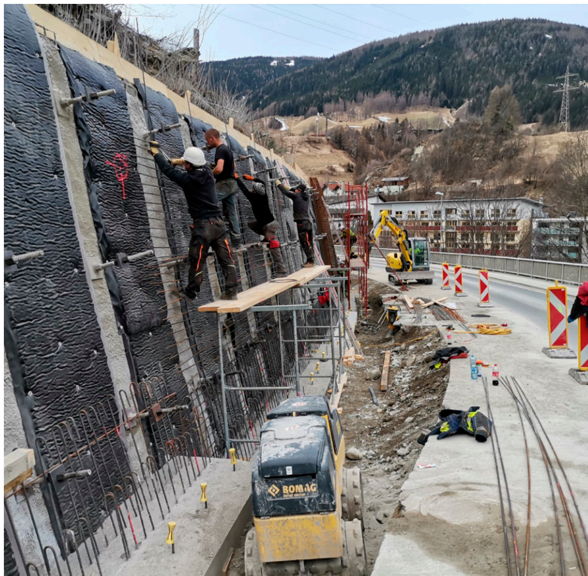
L 38 Ellbögener Straße, Pfoner Eck bis Sillbrücke Mühlbachl
