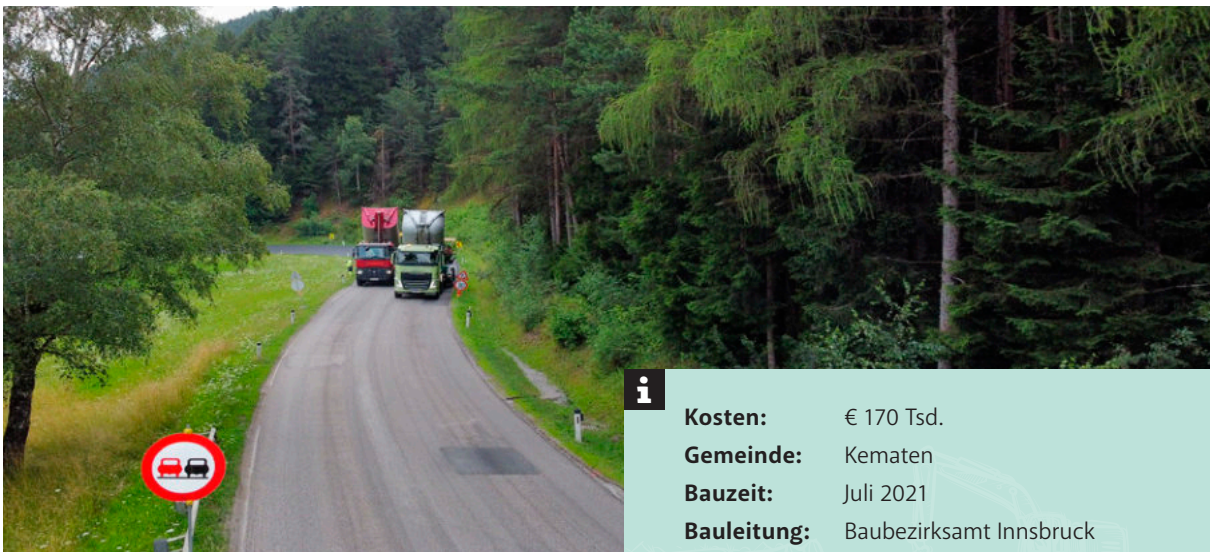
Die Asphaltdeckschicht wird nahtlos mit zwei Asphaltfertigern eingebaut.
