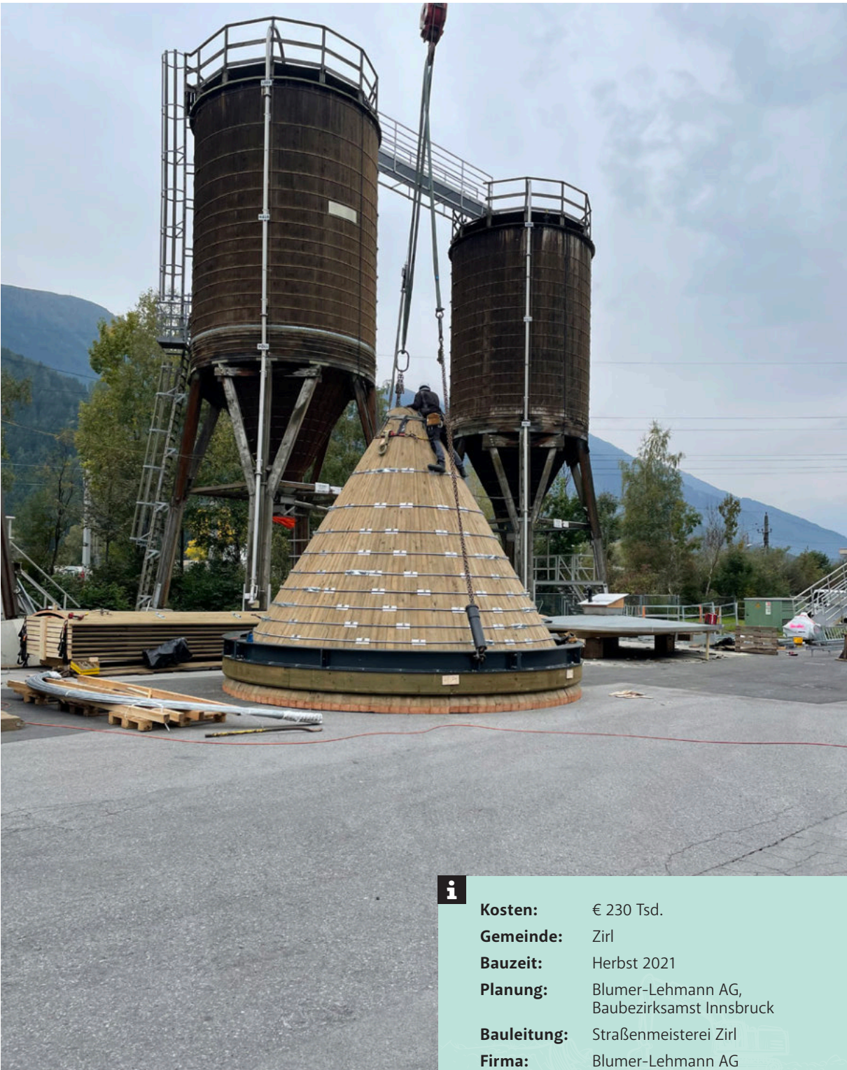
Vorbereitungsarbeiten Trichtereinbau
