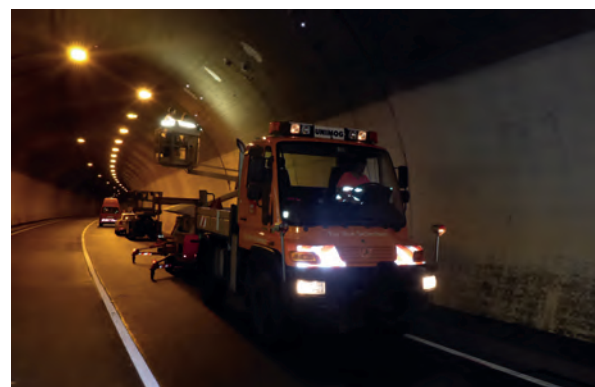
Tunnelprüfung B 179, Unterflurtrasse Nassereith
