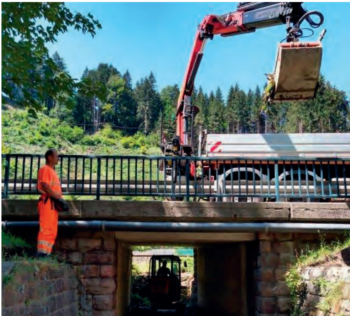
Erhaltungsarbeiten an einem Bachdurchlass unter der B 170 Brixentalstraße
