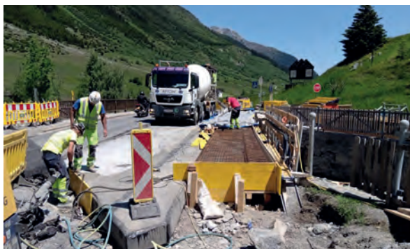
Randbalken betonieren
