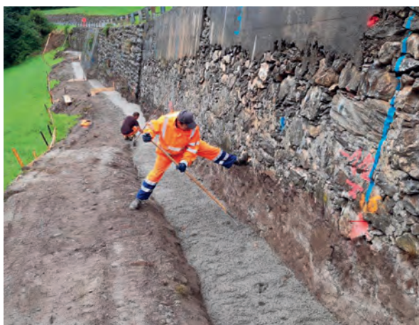
Fundament betonieren
