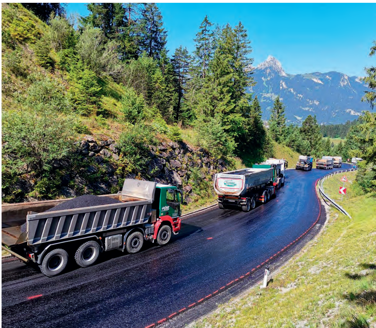
Belagssanierung an der L 255 Planseestraße im Juli 2020
