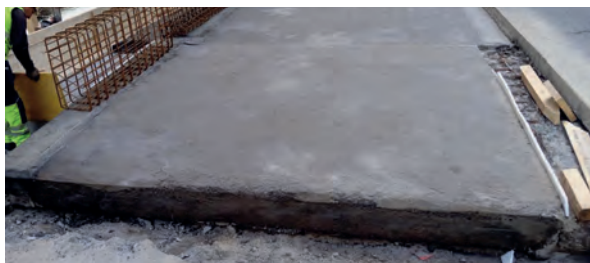
Vor dem Abdichten des Tragwerkes
