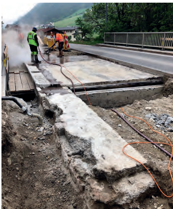
Wasserstrahlen des Tragwerkes
