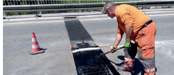
Einbau Belagsdehnfuge
