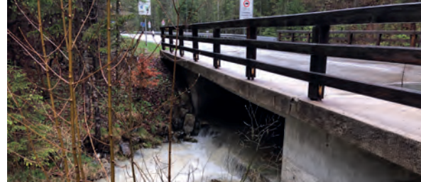
Ansicht vor der Instandsetzung
