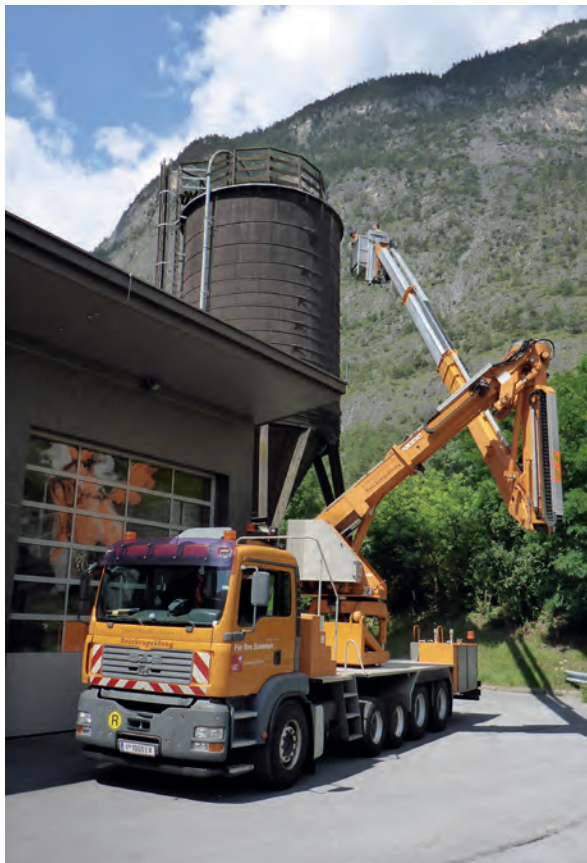
Siloprüfung Straßenmeisterei Zams
