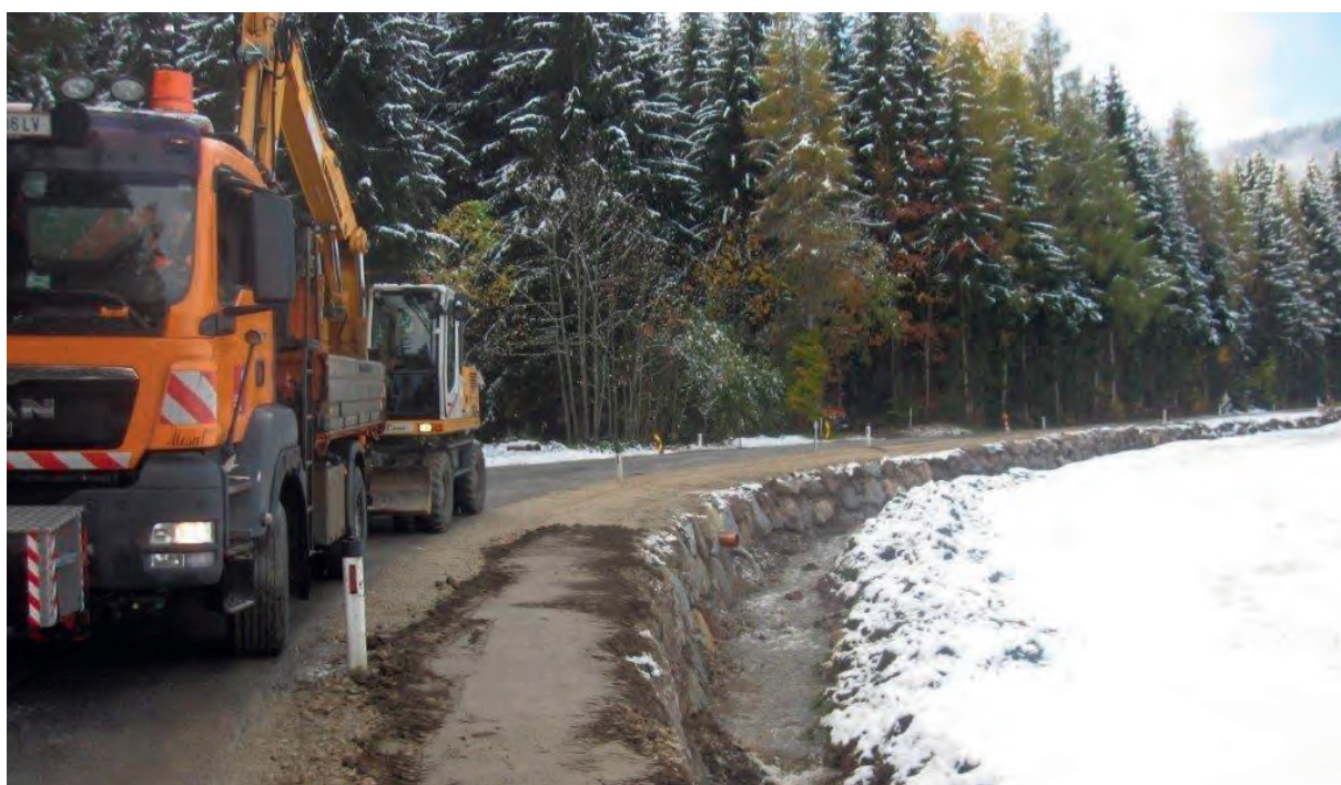
Bachverbauung an der L 42 Penningbergstraße durch die Straßenmeisterei Wörgl
