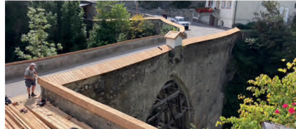
Arbeiten an Brüstungsmauer
