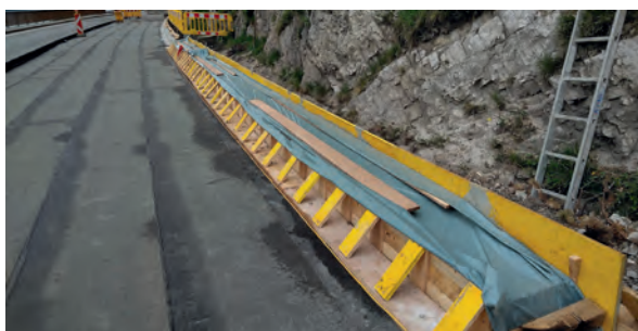
Abtrag alte Brücke
