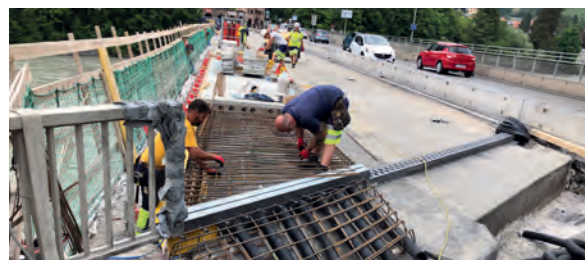
Einbau Bewehrung für Randbalken
