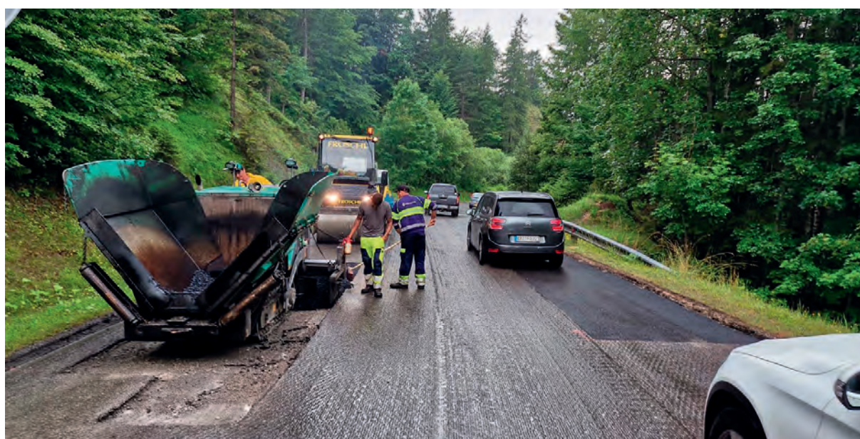
Sanierung der L 255 Planseestraße im Bereich Sägewerk bis Hubertuskapelle
