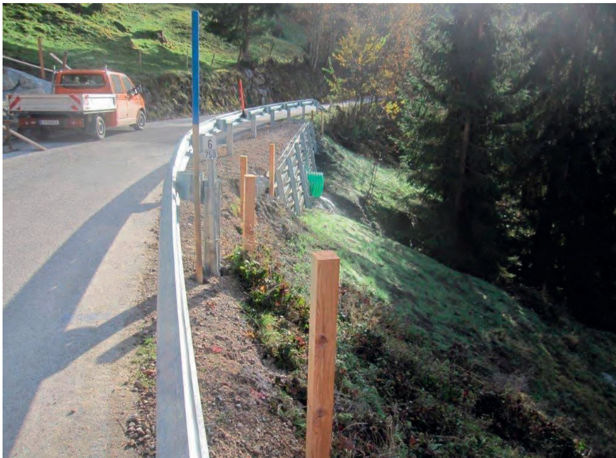
Errichtung einer von der Landesstraßenverwaltung entwickelten neuartigen GFK-Ankerwand an der L 204 Windauer Straße
