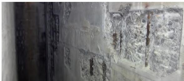
Betonsanierung am Tragwerksende
