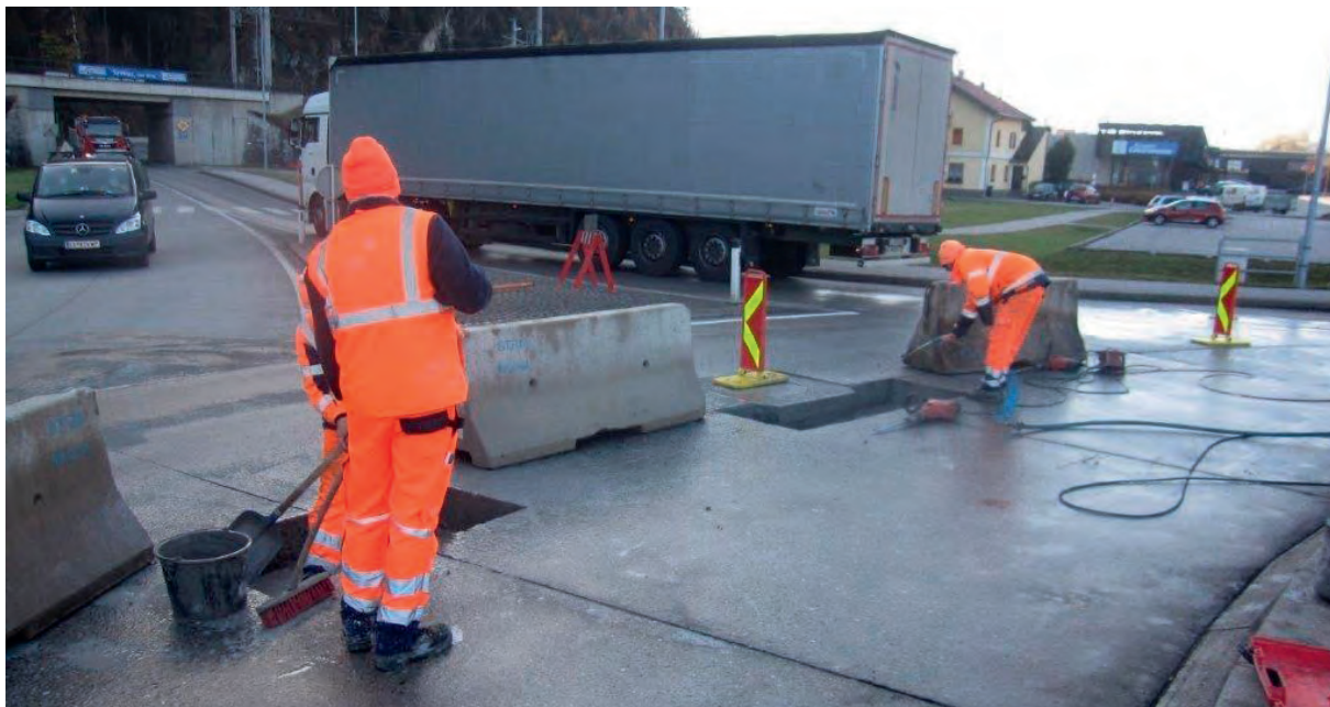
Sanierung des Betonkreisverkehrs an der B 171 Tiroler Straße bei Brixlegg
