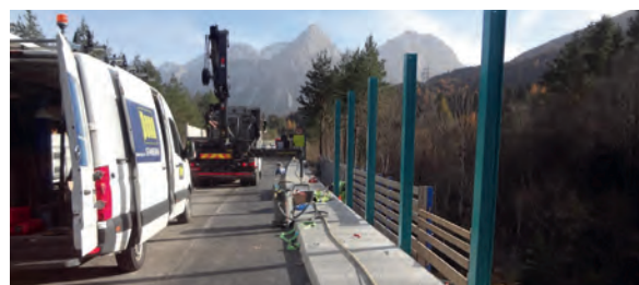
Montage Lärmschutzwand
