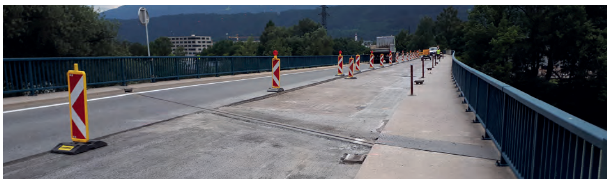
Tragwerksoberseite vor dem Abdichten
