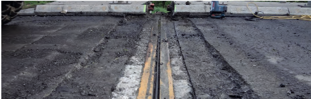
Abtragen der alten Konstruktion
