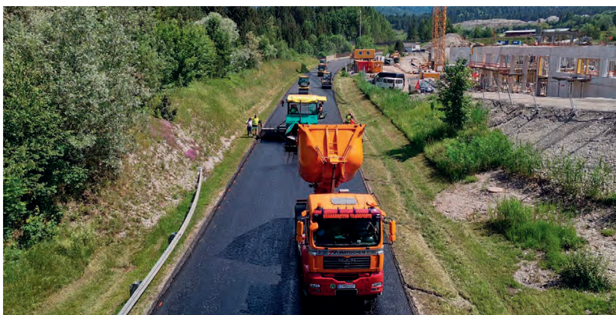
Erneuerung der Deckschicht der B 179 Fernpassstraße bei der Umfahrung Reutte
