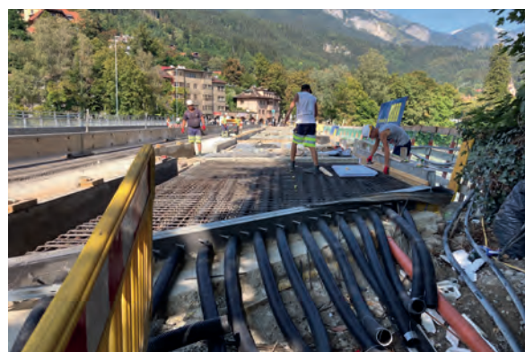
Kabelrohre für Leitungsbetreiber
