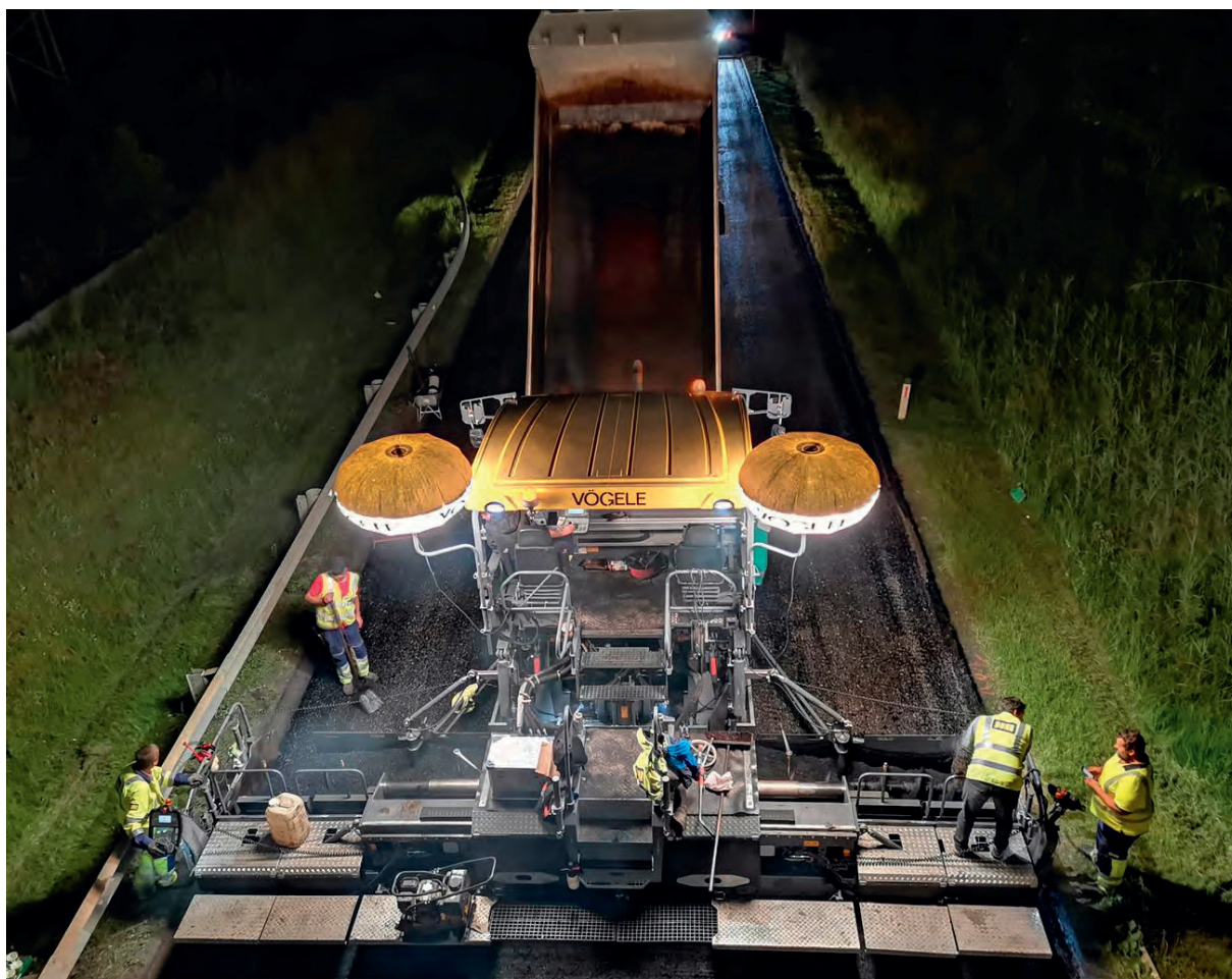
Belagssanierung an der B 179 Fernpassstraße in Nachteinbau im Juni 2020
