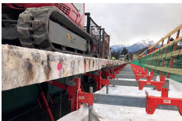
Gerüst für Randbalkenerneuerung
