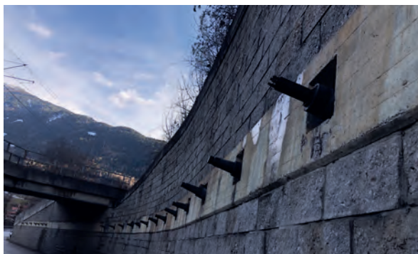
Desolate Ankerkopfabdeckungen
