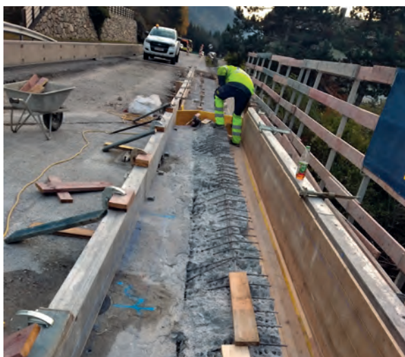
Schalarbeiten Randbalken
