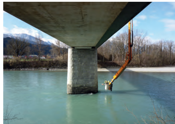
Sohlsondierung B 171a Innbrücke Kranebitten
