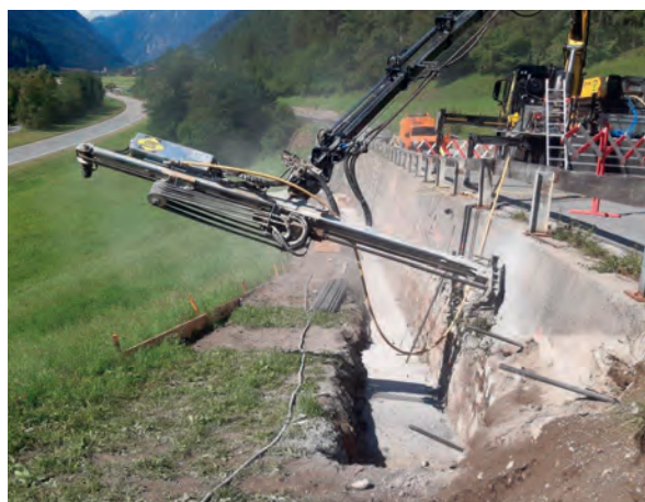
Ankerungsarbeiten
