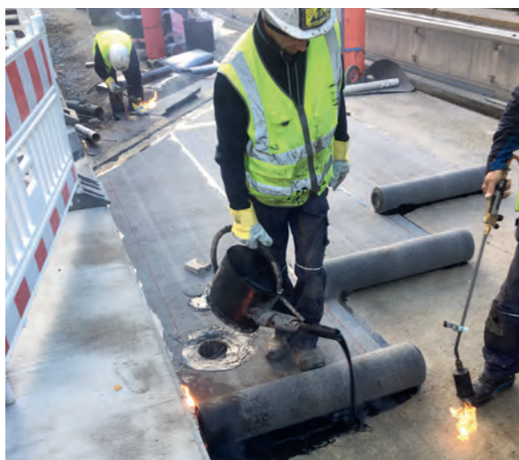
Abdichtungsarbeiten
