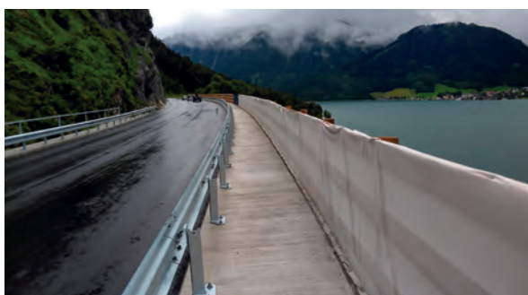
Nach Fertigstellung der Arbeiten
