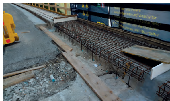
Einheben des Tragwerkes
