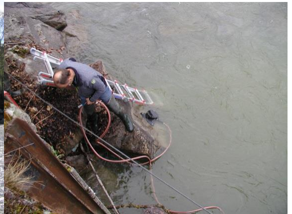
Montage des Einlauftrichters und Zuleitung (Hydrometrische Werkstätte)
