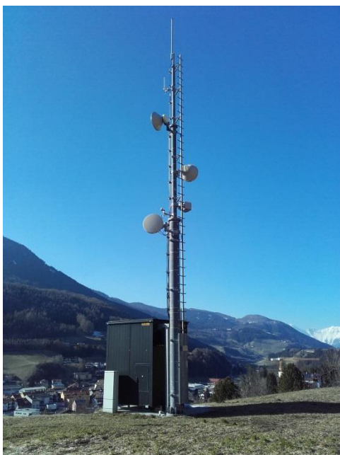
Fotos: Land Tirol, Hydrographischer Dienst; links - Sendestation im Wipptal der Abteilung Zivil- und Katastrophenschutz für das Warn- und Alarmierungssystem Tirol, rechts - Pegel des Hydrographischen Dienstes mit Funkübertragung, St. Jodok/Valserbach
