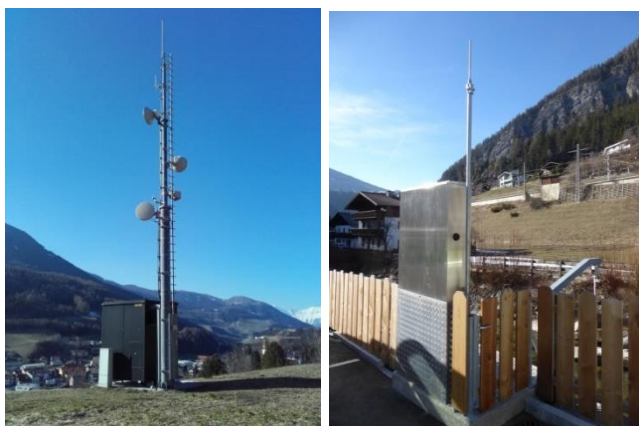
Fotos: Land Tirol, Hydrographischer Dienst; links - Sendestation im Wipptal der Abteilung Zivil- und Katastrophenschutz für das Warn- und Alarmierungssystem Tirol, rechts - Pegel des Hydrographischen Dienstes mit Funkübertragung, St. Jodok/Valsenbach
