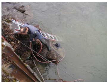
Montage des Einlauftrichters und Zuleitung (Hydrometrische Werkstätte)
