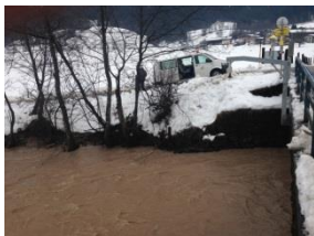
Pegel Reithammer Brücke/Fieberbrunner Ache
