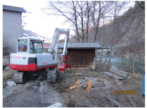
Ein Bagger rollt auf das leere Pegelhäuschen Landeck/Sanna zu, das am 2. März 2012 abgetragen wurde.
