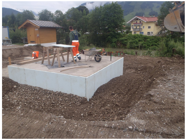
Im Zuge der Großsachen-Regulierung (Hochwasserschutz Kössen) muss der anno 1991 errichtete Pegel Kösse-Hütte/Großache (im Bild links) verlegt werden. Im Vordergrund das Fundament des Ersatzpegels, der im Jahre 2013 in Betrieb gehen wird.
