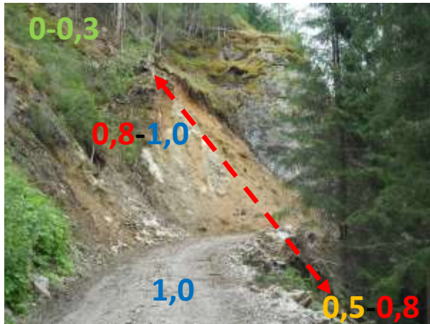
Abbildung 8: Forstweg im Istalanzbach. Im Mittel ist für die ganze Breite (rot strichlierte Linie) mit Abflussbeiwerten zwischen 0,8 und 0,9 bzw. für die Straße auf 5 m Breite mit 1,0 zu rechnen.
