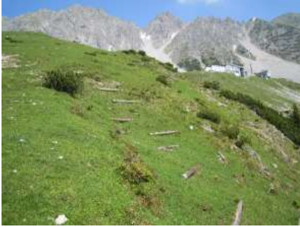
Abbildung 9: Piloten - einfache Erosionssicherung mit quergelegten und -fixierten Bäumen. Dadurch wird die Erosion vermindert, Feinmaterial akkumuliert und das Ankommen von Vegetation (auch von Pionierhölzern) erleichtert.
