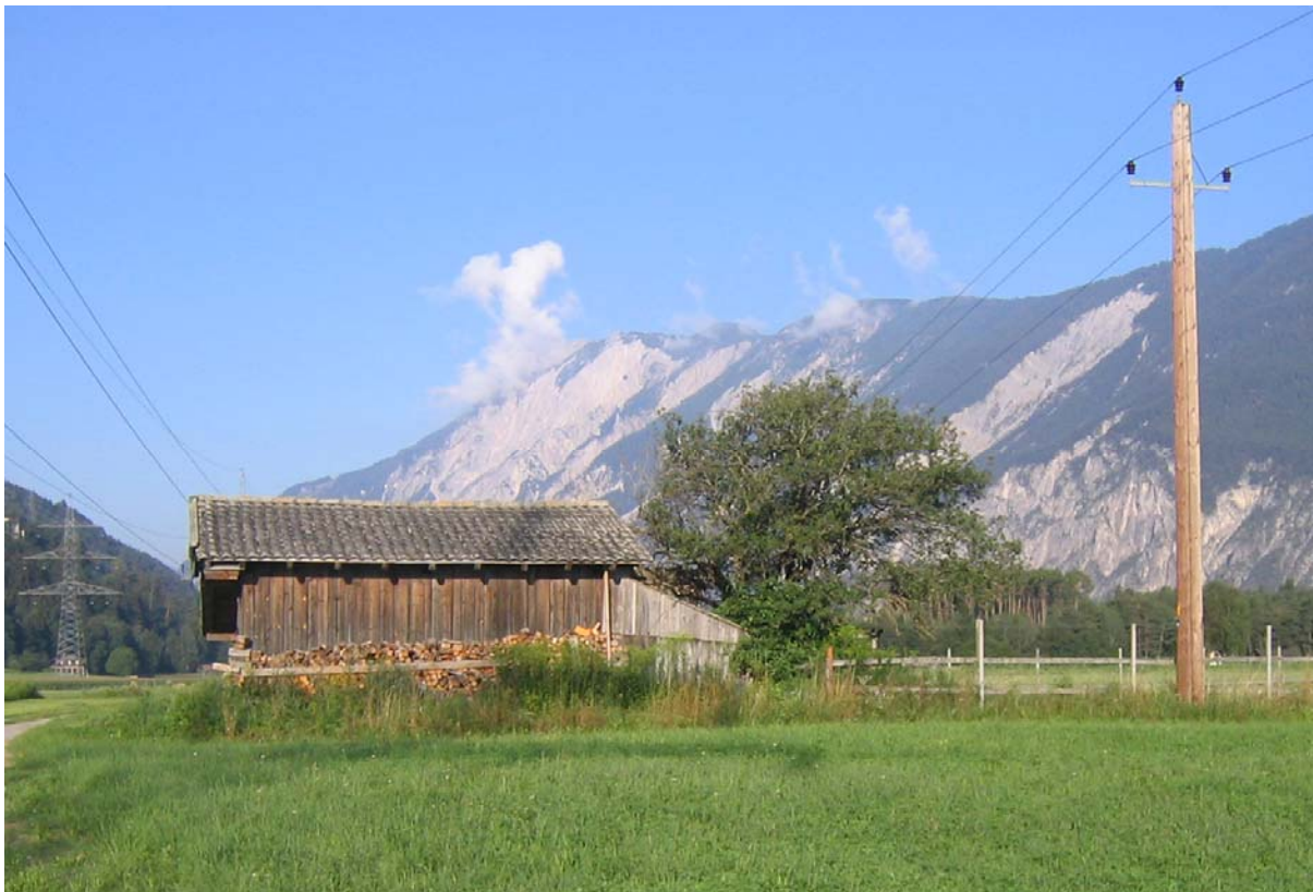
Abb. 8: Typische Strukturen im Natura 2000 Gebiet: 25-kV-Stromleitung mit Holzmasten (rechts), Einzelbaum / -gebüsch und Stadel (Mitte); Starkstromleitung mit Metallmasten (links).
