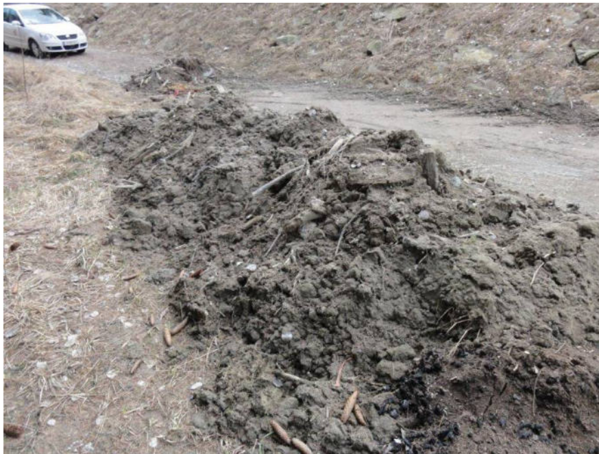
Abbildung 6: Getrennt ausgehobener Bereich mit Murholz
