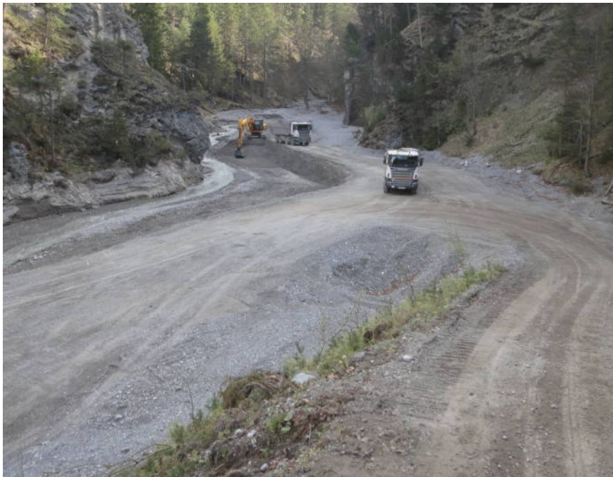
Abbildung 2: Mechanische Räumung mittels Bagger
