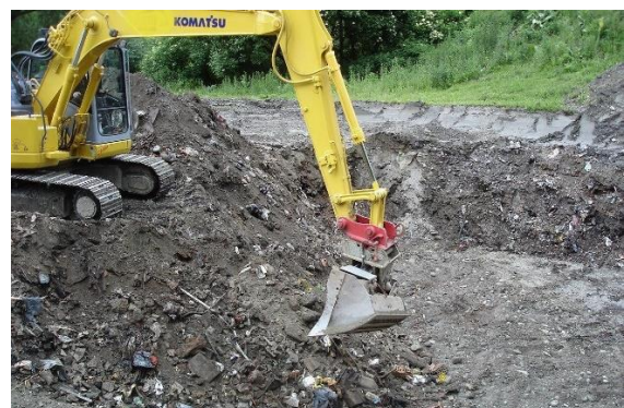
Abbildung 6: Aushub mittels Bagger (gemischte Abfälle bis zur Deponiesohle)
