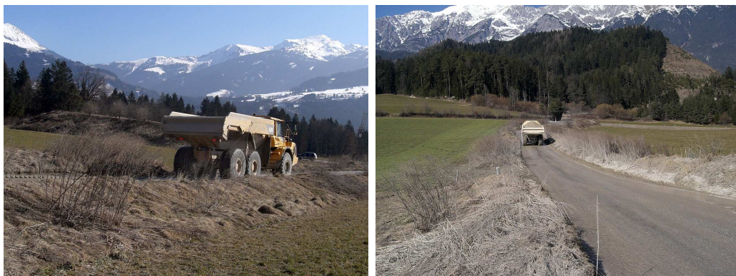
Abbildung 3.47: LKW - Fahrzeugbewegungen auf einer gekehrten, befeuchteten und befestigten Fahrbahn. Sowohl optisch als auch am Messgerät kann keine Staubemission festgestellt werden.
