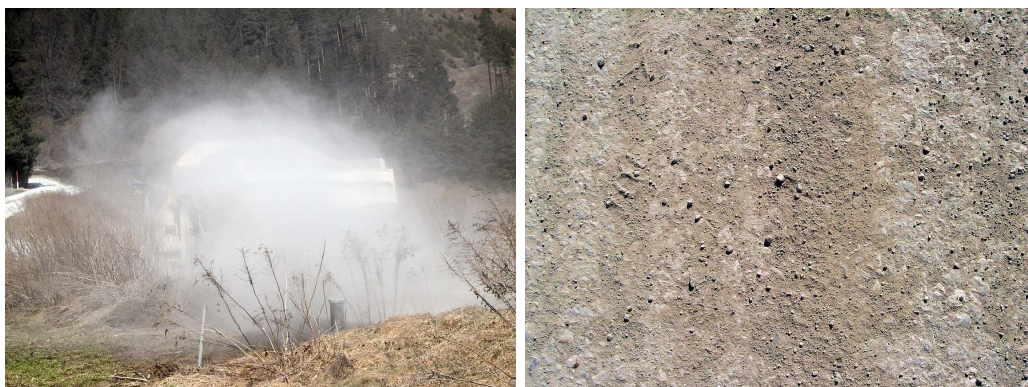
Abbildung 3.42: Diffuse Staubemission auf einer stark verschmutzten Fahrbahn (links). Verschmutzte Fahrbahnoberfläche (rechts, Bildausschnitt rund 0,5 m)
