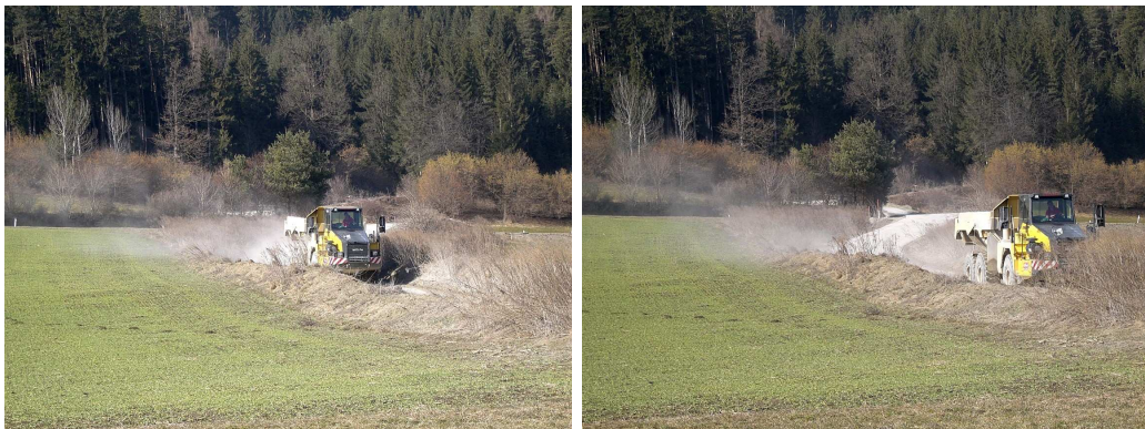
Abbildung 3.50: 1,5 Stunden nach der Befeuchtung treten wieder sichtbare Staubemissionen auf; die Staubfahnen sind bis in eine Entfernung von 30 m sichtbar
