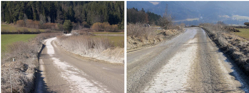
Abbildung 3.49: Nach ca. 1,5 Stunden trocknet die befestigte Fahrbahn bereits auf. Abschnitte mit günstiger Neigung zur Sonneneinstrahlung sind bereits völlig trocken.
