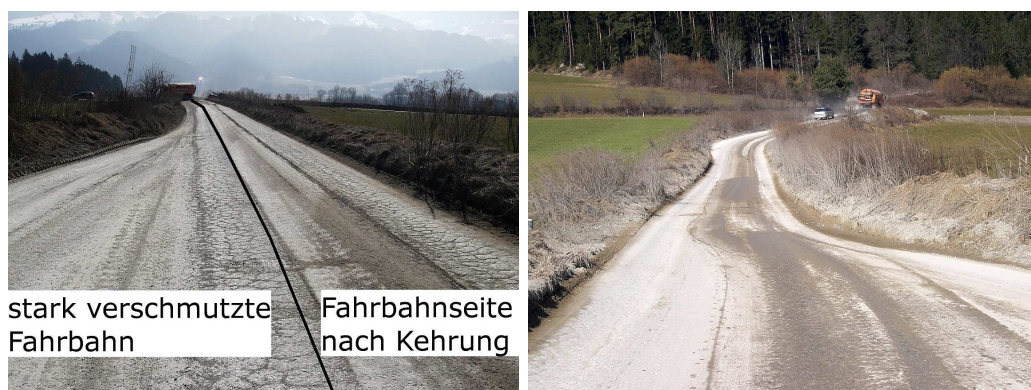
Abbildung 3.45: Fahrbahnoberfläche vor und nach dem Kehrvorgang (links). Befestigte Baustraße nach dem Kehrvorgang, die Kehrmaschine verlässt das Betriebsareal wieder (rechts).
