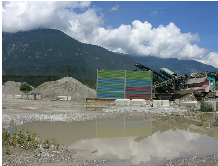
Abbildung 3.4: Foto vom 04.08.2010 der Aufbereitungs- und Betonmischanlage I in Weer
