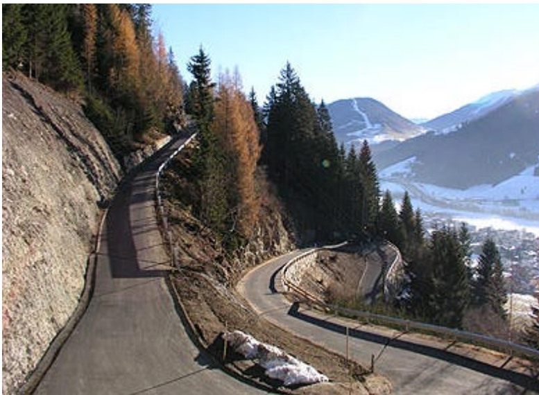
... und generalsanierte Sillianbergstraße (Bauabschnitt I)
