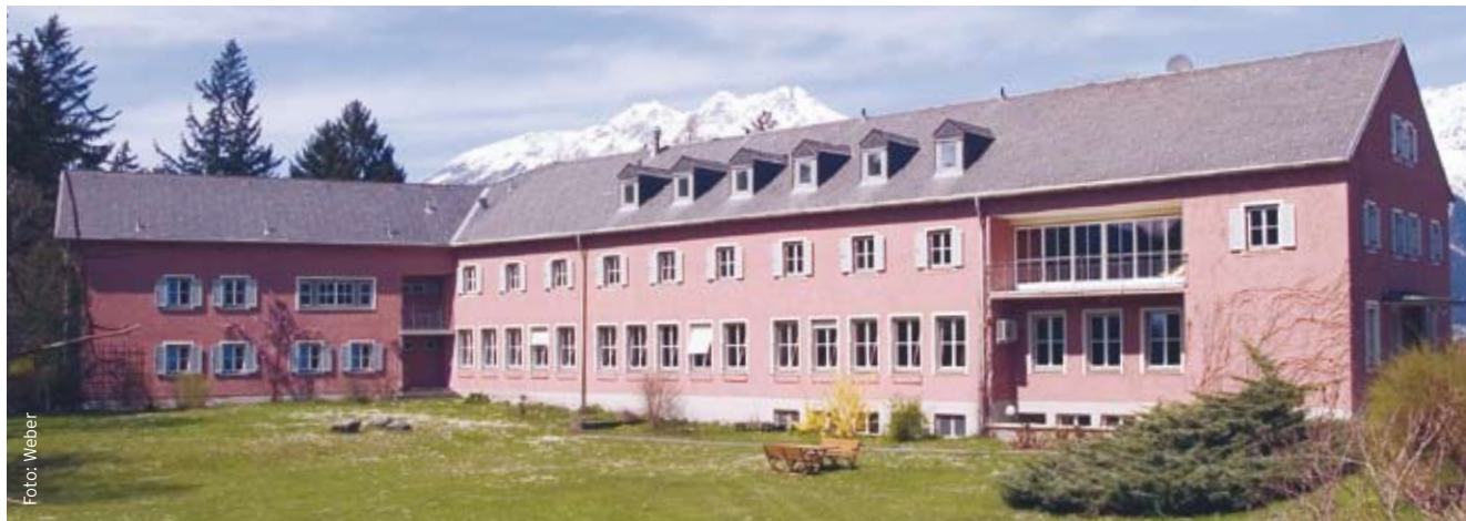
Grillhof Südansicht. Das Haupthaus wird ab Herbst 2012 generalsaniert
