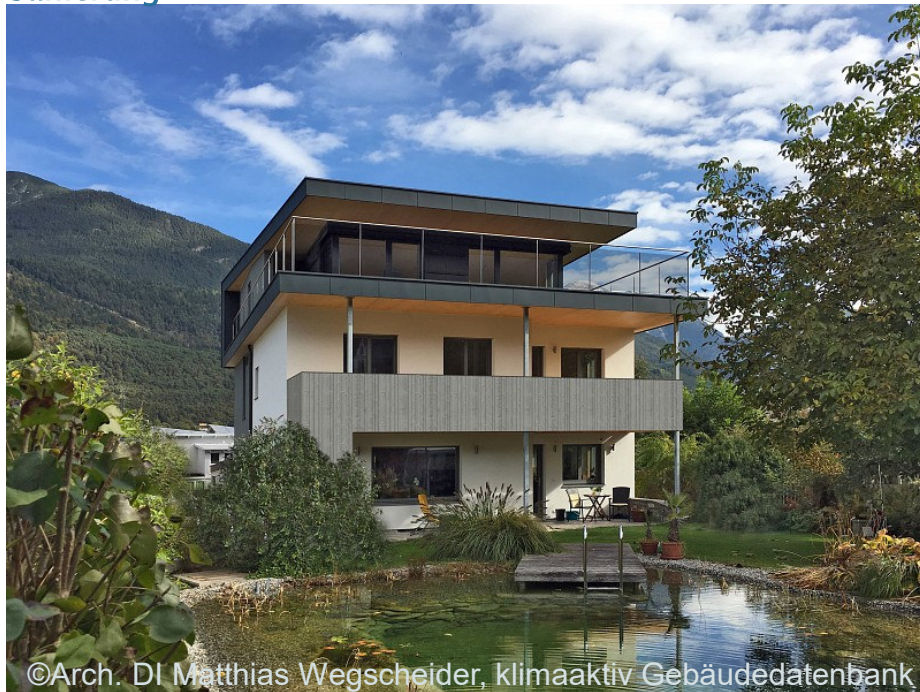
Zweifamilienhaus Kneisl, Inzing, klimaaktiv Gold Sanierung
