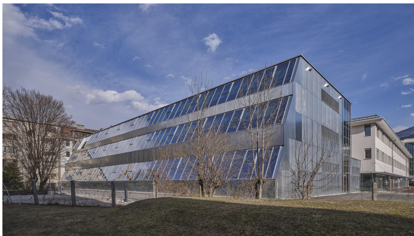
Bild 2: Neubau des Werkstattgebäudes der TFBS für Metalltechnik (Foto: Günter Richard Wett)
