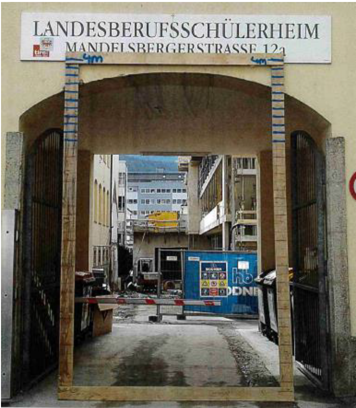
Bild 4: Zufahrt durch nordöstlichen Torbogen, die Außenkante der Holzkonstruktion (2,70 m x 4,10 m) markierte die benötigte Höhe zur sicheren Durchfahrt (Foto: Land Tirol)
