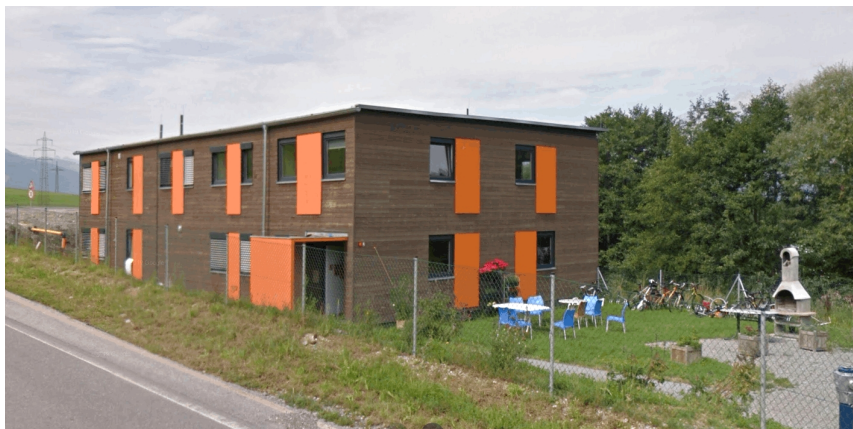
Bild 4: Holzhaus in Modulbauweise in Sistrans/Aldrans (Quelle: Google StreetView, aufgenommen im Mai 2019 [24.11.2021])
