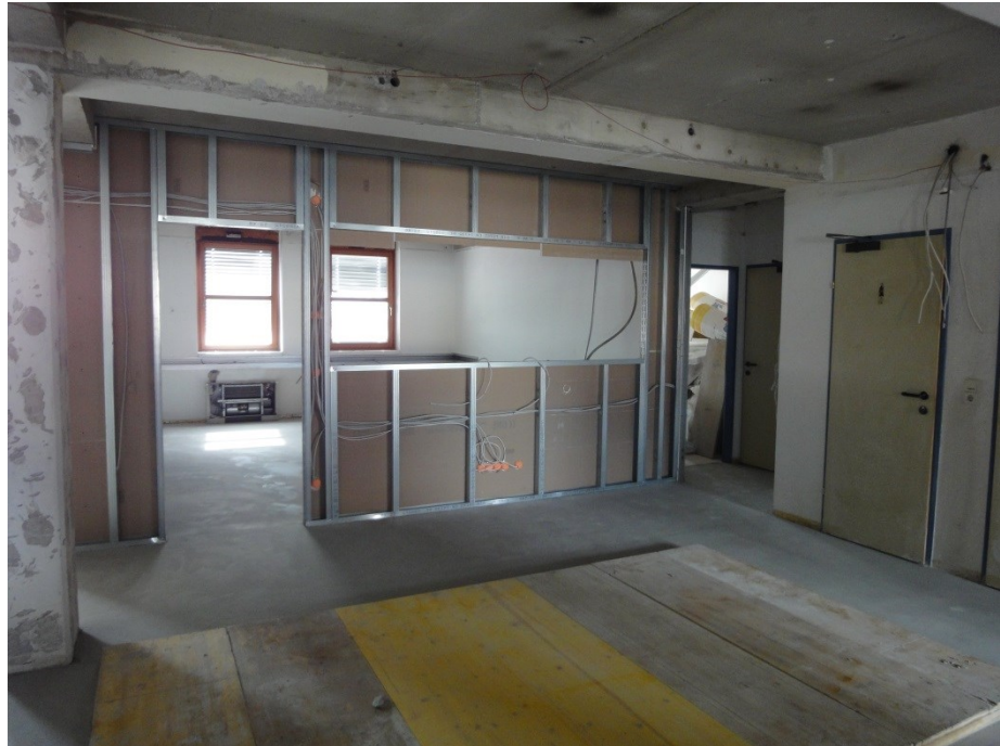
Bild 2: Büroausbau im Jahr 2015 (Quelle: Energie Tirol)
