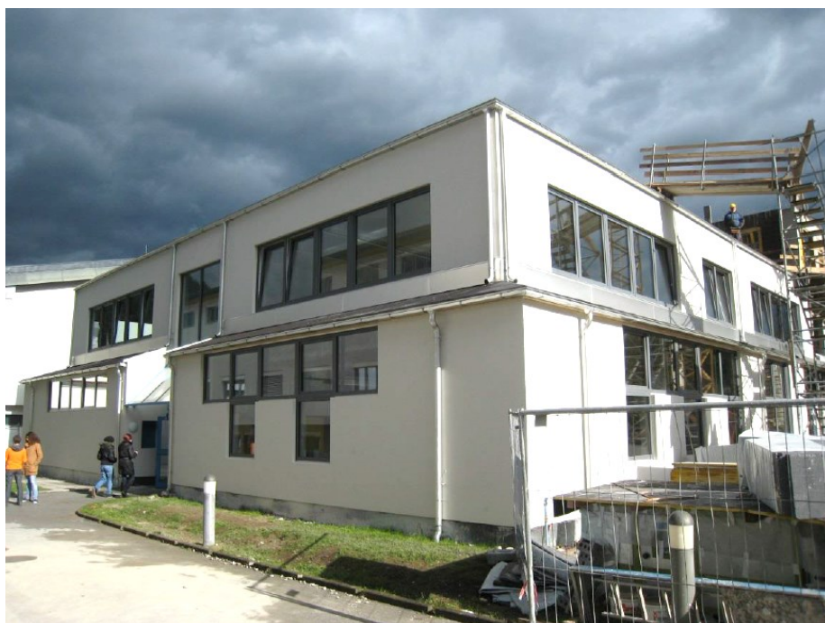
Bild 7: Bauarbeiten am Zubau während laufendem Schulbetrieb (16.10.2013) Foto: planender Architekt
