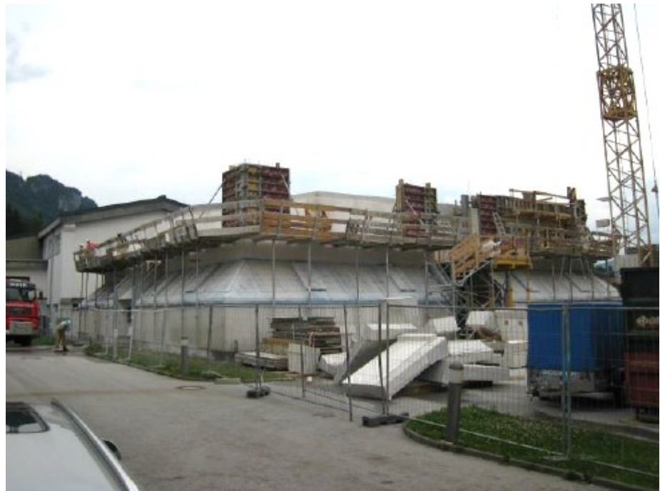
Bild 6: Bestandsgebäude nach Rückbau bis zum 1. Obergeschoß (3.7.2013) Foto: planender Architekt
