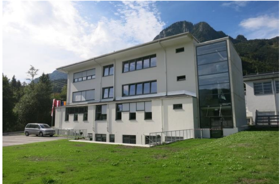
Bild 8: Ost-Ansicht des HTL-Zubaus (19.9.2014) Foto: planender Architekt
