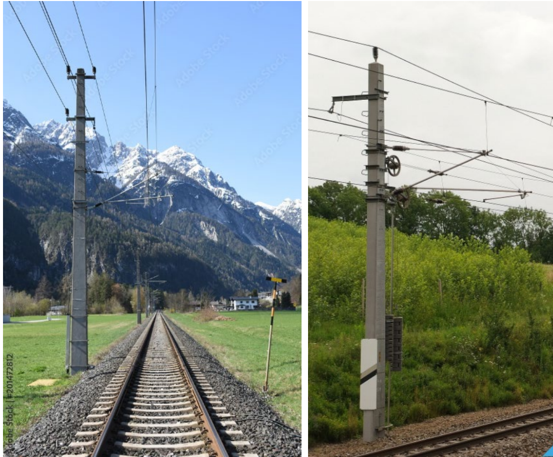
Abbildung 58: typischer Oberleitungsmasten mit Speiseleitung im Osttiroler Pustertal, © stock.adobe.com/201472812, © Plasser&Theurer
