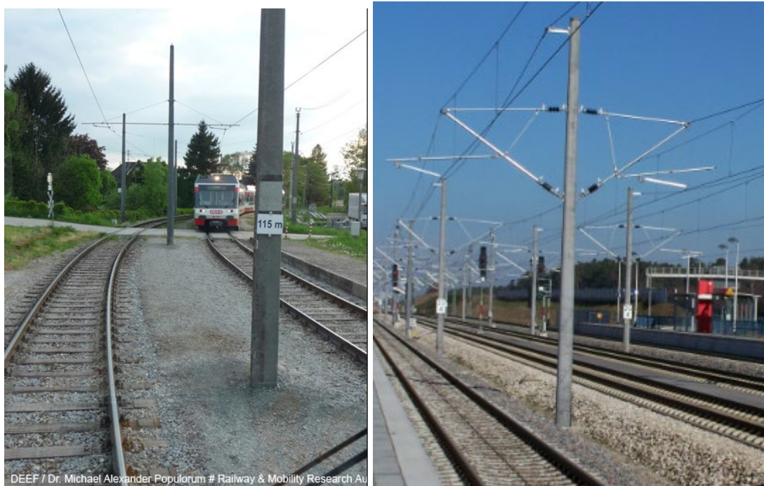
Abbildung 4: Beispiele von Mittelmasten, links mit DC (Leonding, 3. 5. 2011), rechts mit AC-Oberleitung © www.dokumentationszentrum-eisenbahnforschung.org , © Miniatur Wunderland Forum
