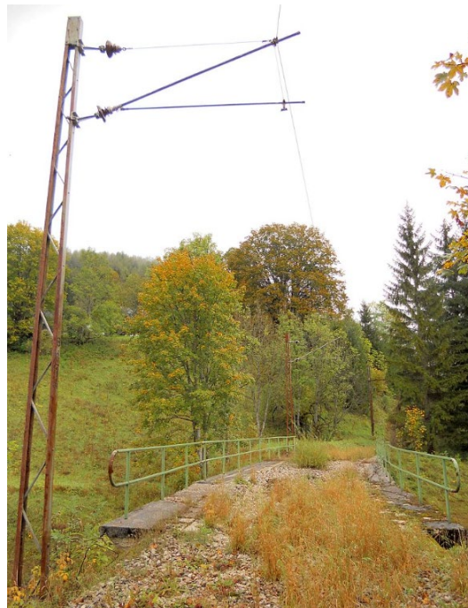
Abbildung 13: Originalfahrleitung der Mariazellerbahn mit genieteten Gittermasten von 1910 stillgelegter Streckenabschnitt nach Gußwerk © 2012 BikeMike, wikipedia
