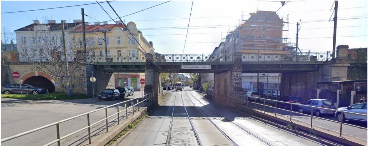
Abbildung 15: Minimale Fahrdrathöhe von rund 4,5 m (Anschrift 4,40m) über SOK bei 600V DC bei den Wiener Linien, Linie 52, Linzerstraße, abgesenkt © google street view (04/2022)
