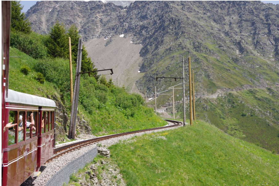
Abbildung 60: originale und neue Oberleitungsmasten der TMB während der Erneuerung bei vollem Planbetrieb, im hinten liegenden Streckenabschnitt ist die Oberleitung vorhanden, aber nicht ersichtlich, © MfV 3128
