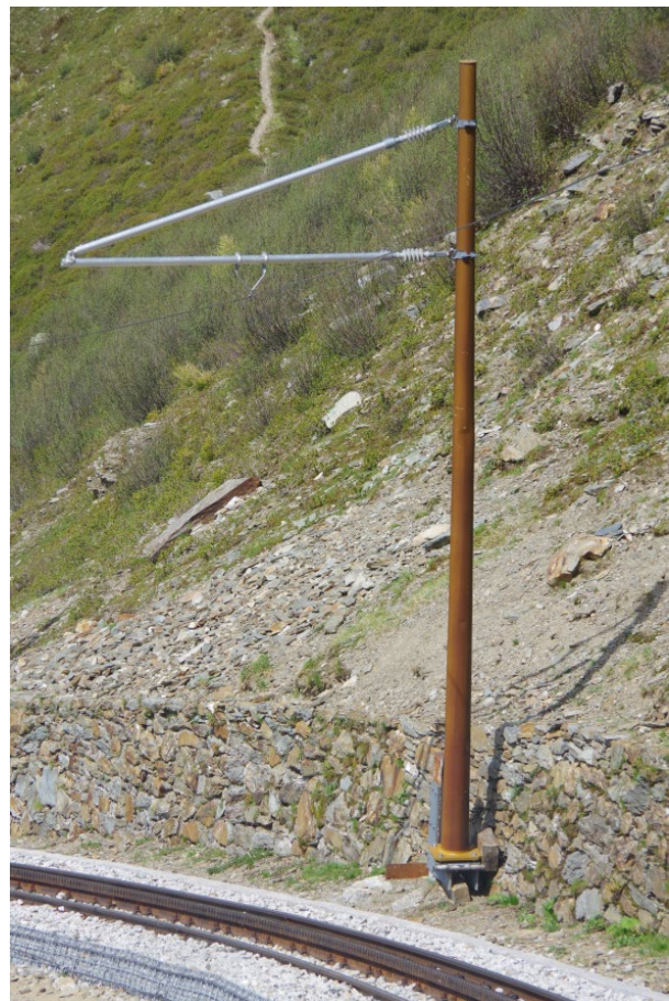
Abbildung 61: neue Oberleitungsmasten der TMB aus Holz (links) und folienbeschichtetem Stahl in Holzoptik (rechts) © MfV 3110, 3137
