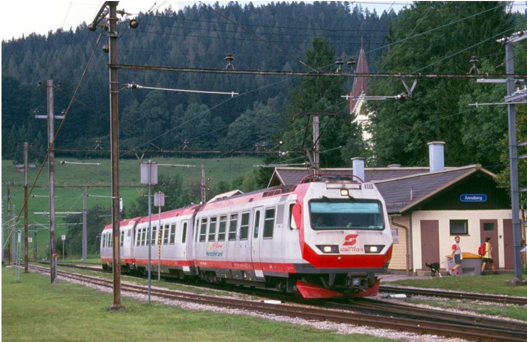
Abbildung 12: Originalfahrleitung der Mariazellerbahn mit Querjochen von 1910 Ausleger und Isolatoren wurden im Rahmen der Wartung erneuert © 24.08.2002 Herbert Ortner, wikipedia
