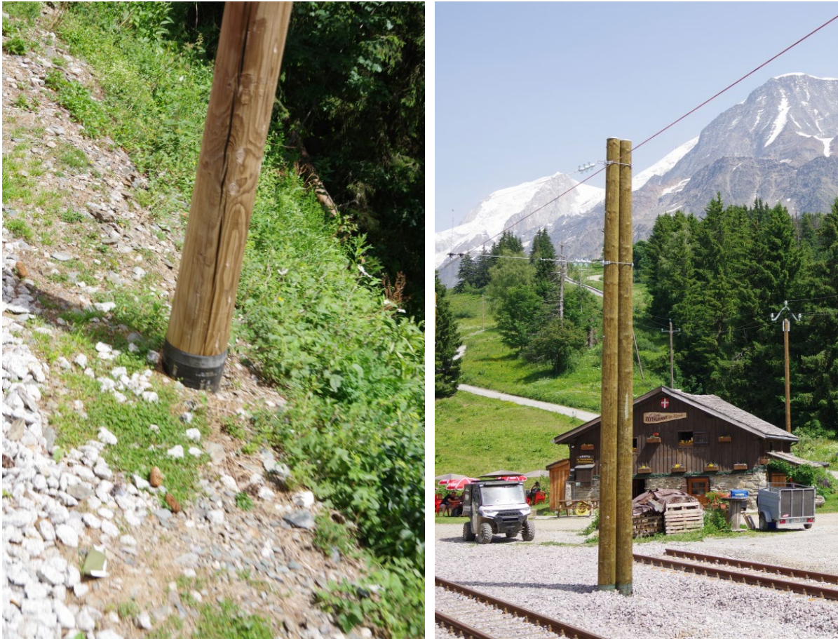
Abbildung 62: direkte Fundierung der Holzasten mit Faulschutz, Doppelholzmasten für Aufnahme der Querseile (Turmmasten) bei der TMB, © MfV 3052, 3096
