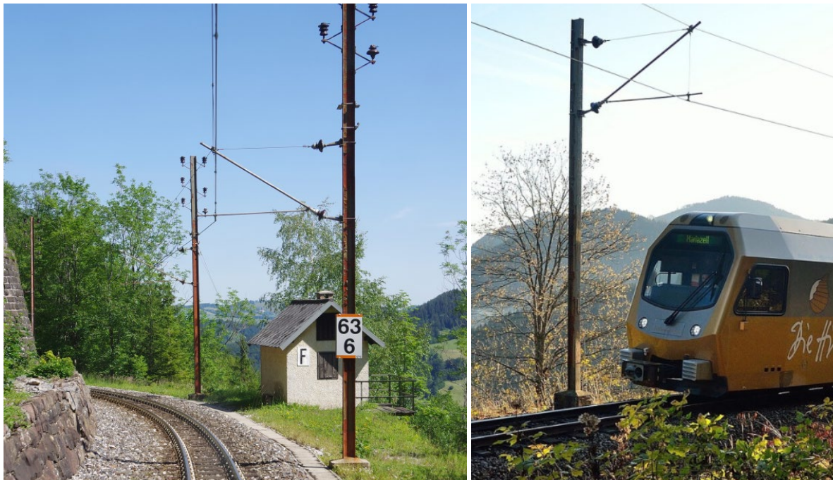
Abbildung 11: links: Originalfahrleitung der Mariazellerbahn mit (demontierter) Speiseleitung von 1910 © 2022: MfV IMGP5082, IMGP5052, rechts: gewöhnlicher Streckenmast © Niederösterreich Bahnen
