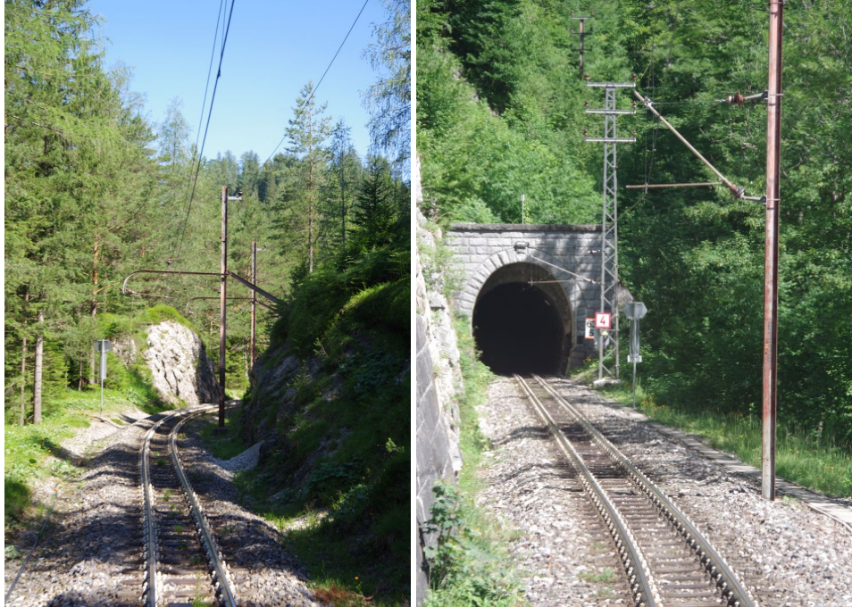
Abbildung 10: Originalfahrleitung der Mariazellerbahn von 1910 © 2022: MfV IMGP5082, IMGP5051
